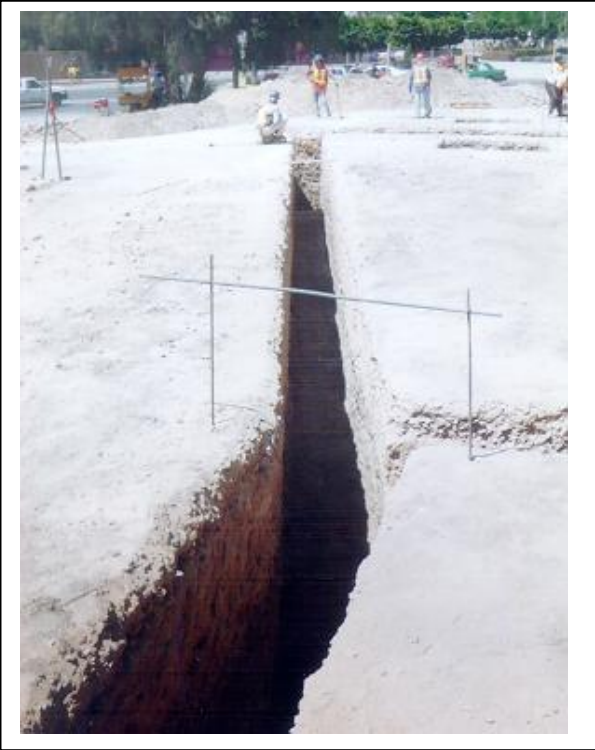
Foto 17 Trazo y Excavación de trincheras para tuberías de producto
