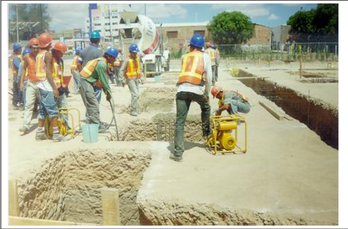
Foto 9 Preparación y armado de la cimentación para la techumbre
