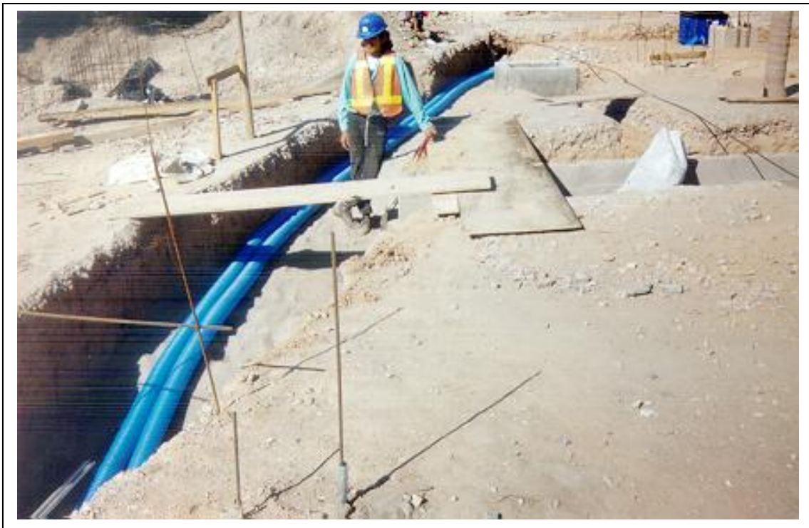
Foto 18 Tendido de las tuberías de producto en las trincheras
