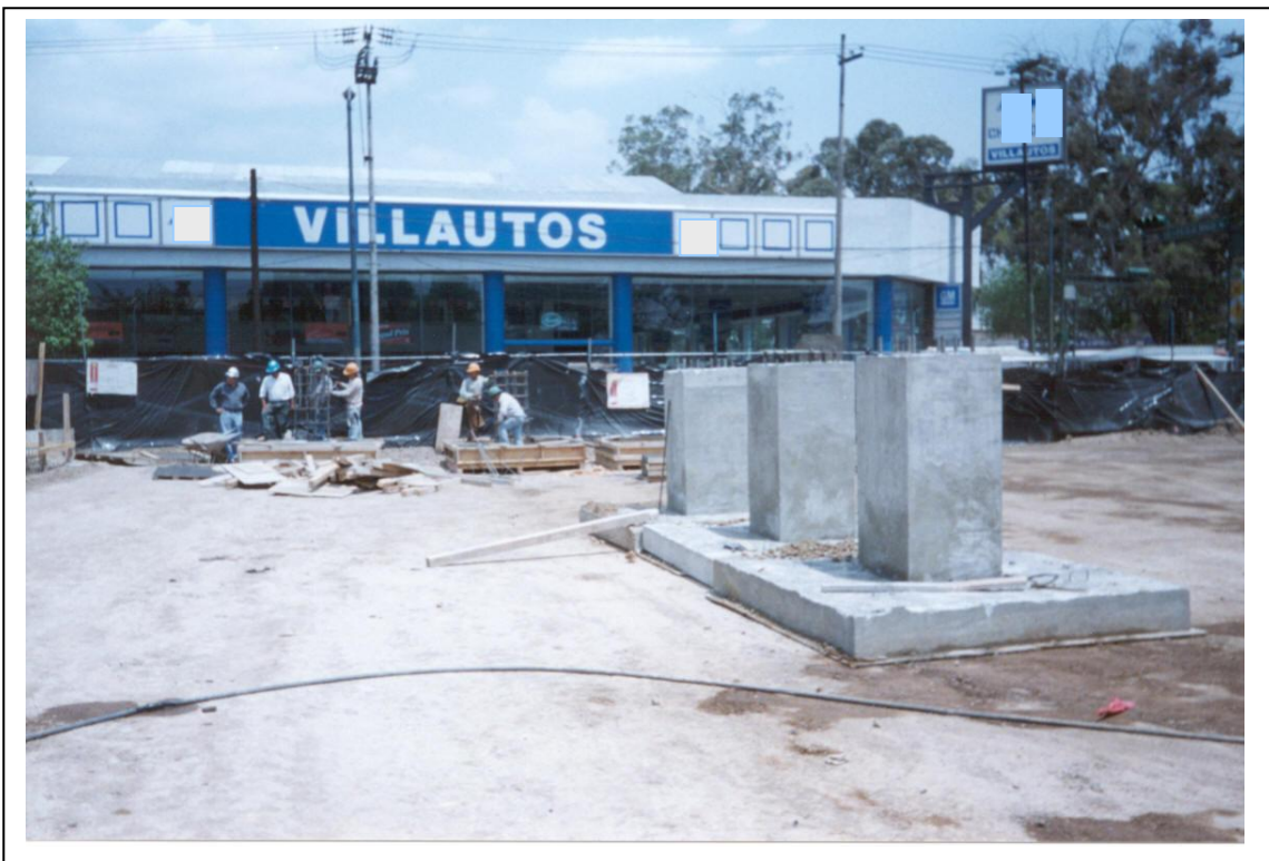
Foto 12 Zapatas precoladas terminadas
