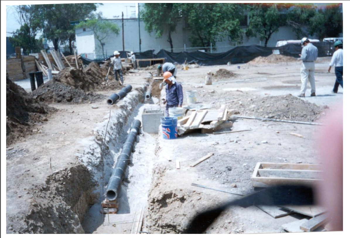
Foto 15 Tendido de tubería para aguas aceitosas
