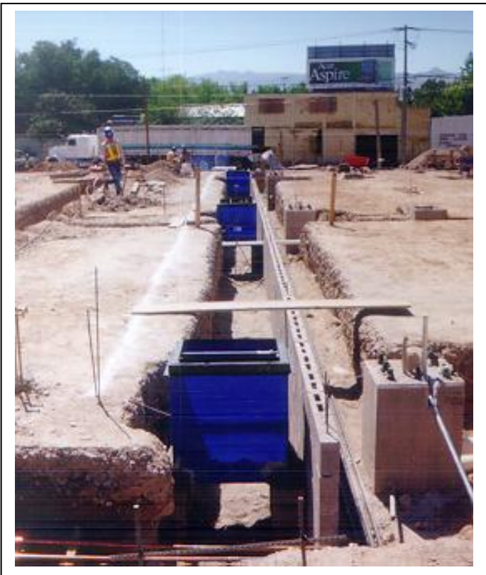
Foto 22 Colocación de contenedores para dispensarios de gasolina e instalación para dispensarios de agua y aire
