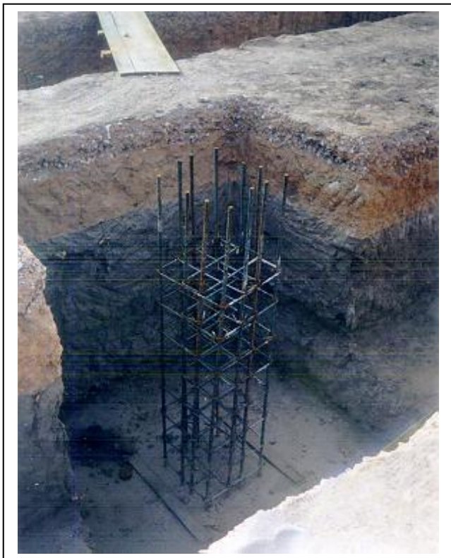
Foto 9 Preparación y armado de la cimentación para la techumbre
