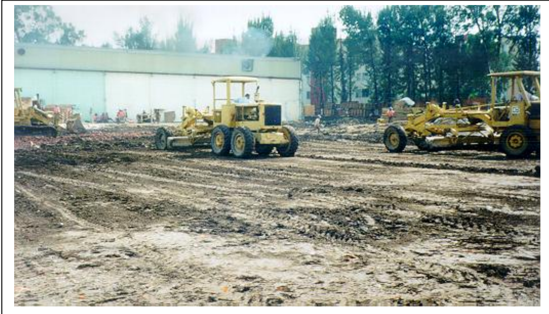
Foto 1 Nivelación del terreno con motoconformadora
