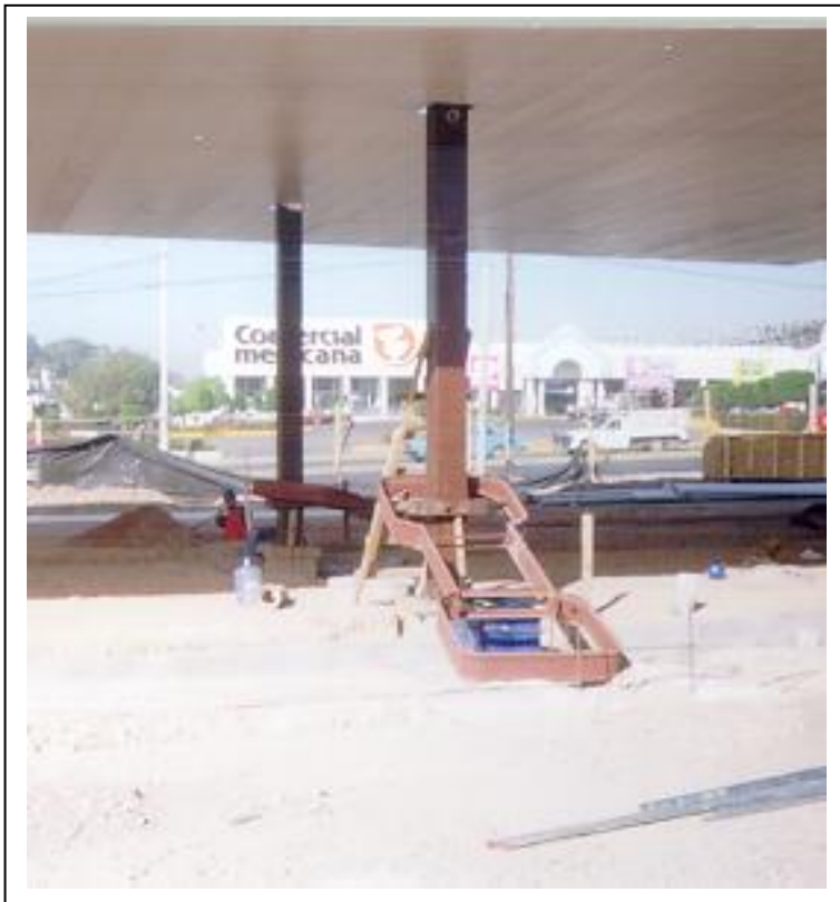
Foto 13 Colocación de las columnas de acero para la techumbre
