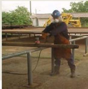
**CALIBRACIÓN DEL DIAMETRO EXTERIOR DE LA TUBERIA Y JUNTAS**
