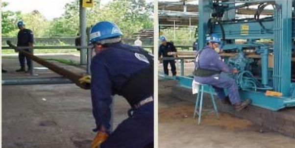
**LIMPIEZA INTERIOR: CON AIRE A PRESIÓN Y AGUA PARA ELIMINAR RESIDUOS.**
