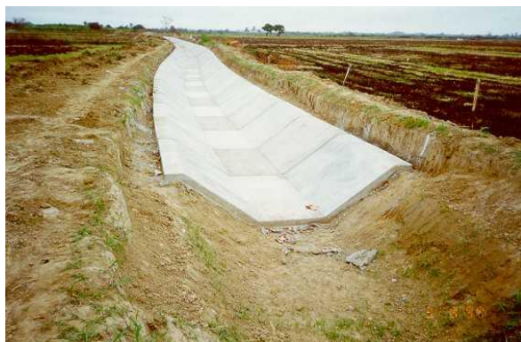
Figura No. 7. Canal típico de concreto para conducción.
