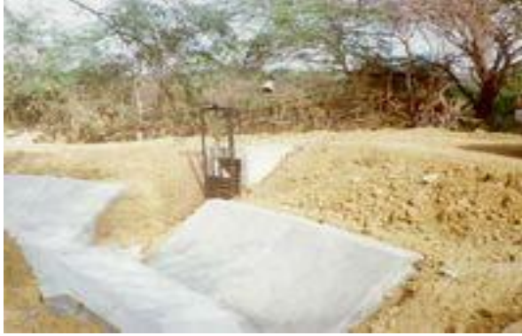
Figura No. 8. Interconexión de canales a cielo abierto.
