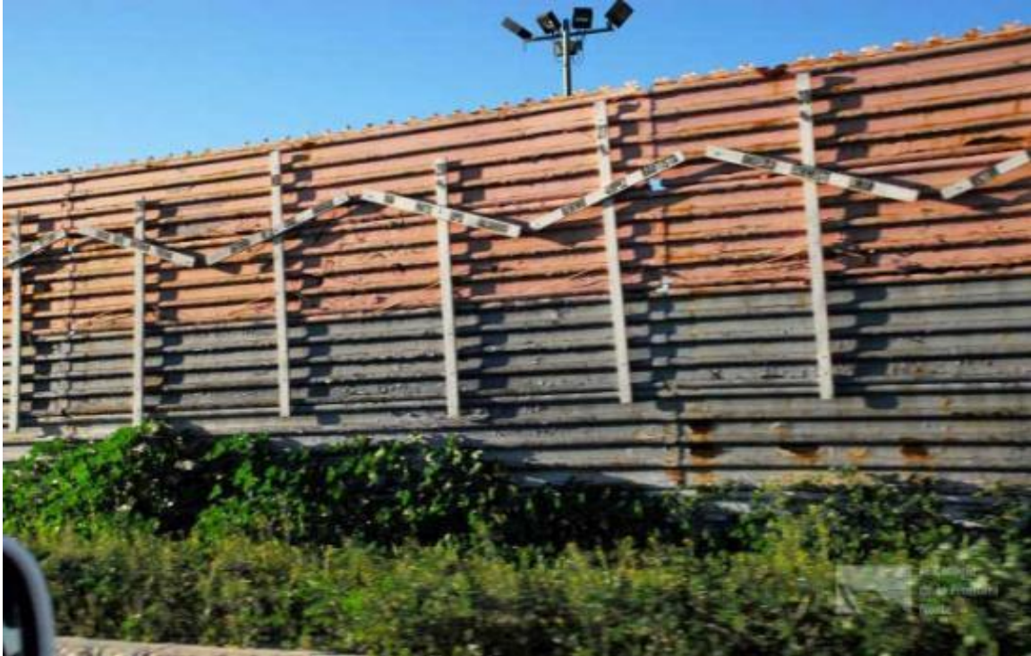
Barda con cruces frente al aeropuerto. Alfonso Caraveo Castro, Tijuana, http://aplicaciones.colef.mx/acervofoto/main.php?g2_itemId=3912
