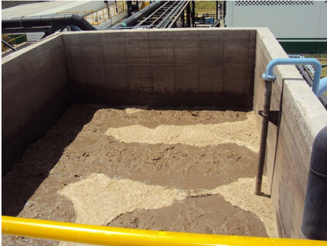
Figura 3.- Tanque de almacenamiento de lodos provenientes de los reactores biológicos.
