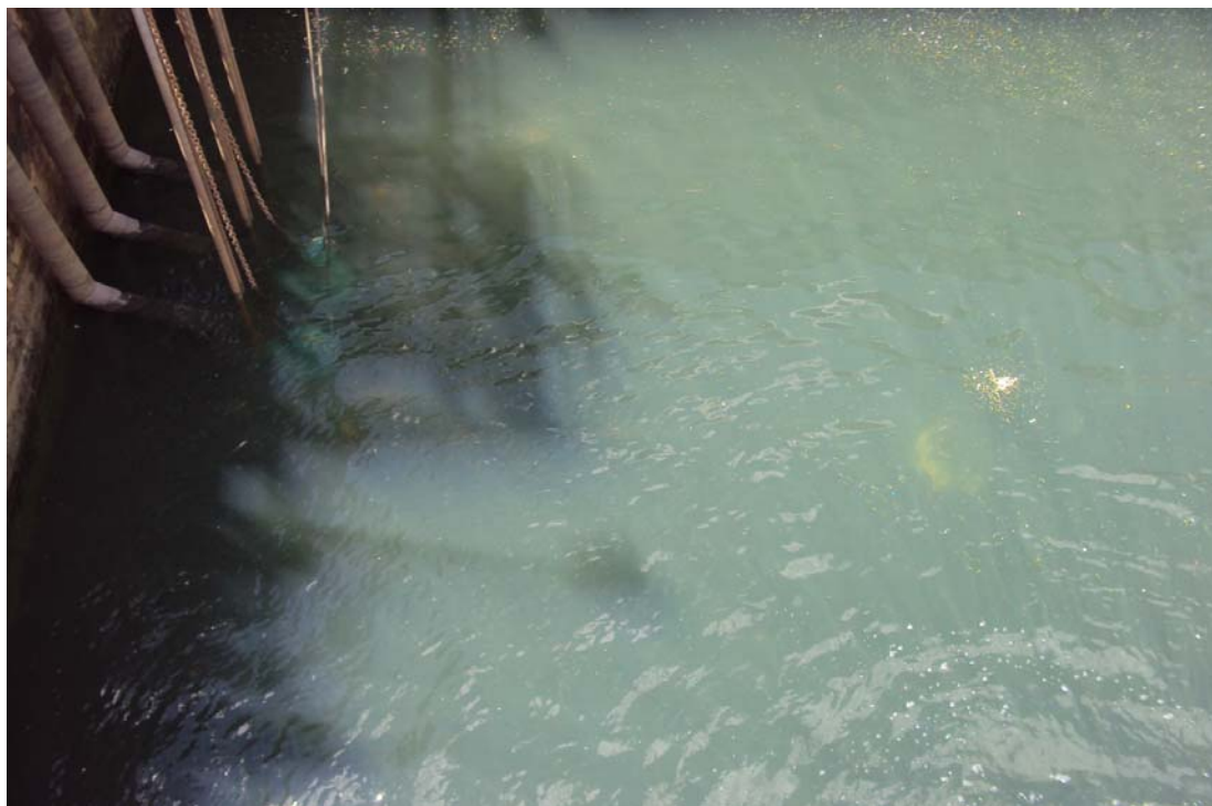
Figura 4.- Tanque secundario donde se realiza la desinfección del agua tratada con hipoclorito de sodio al 13%.
