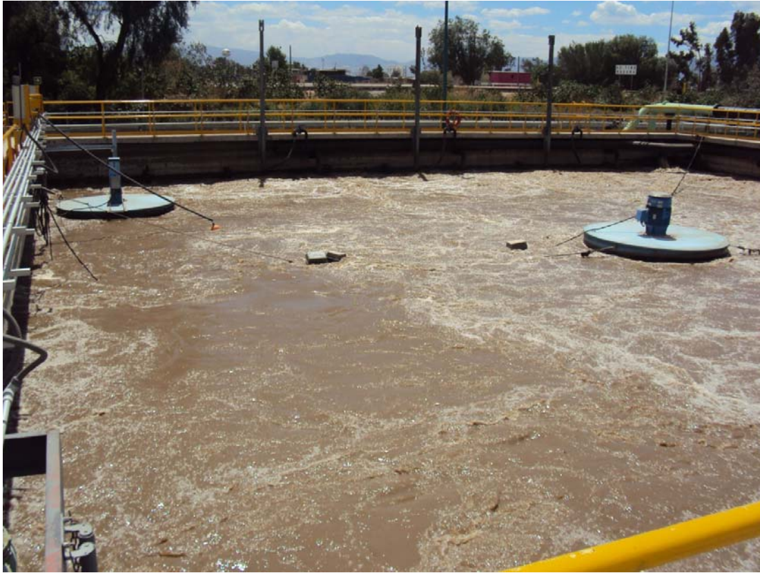
Figura 2.-Reactor biológico, aquí es donde se desarrolla la fase de desnitrificación, nitrificación y remoción de materia orgánica.
