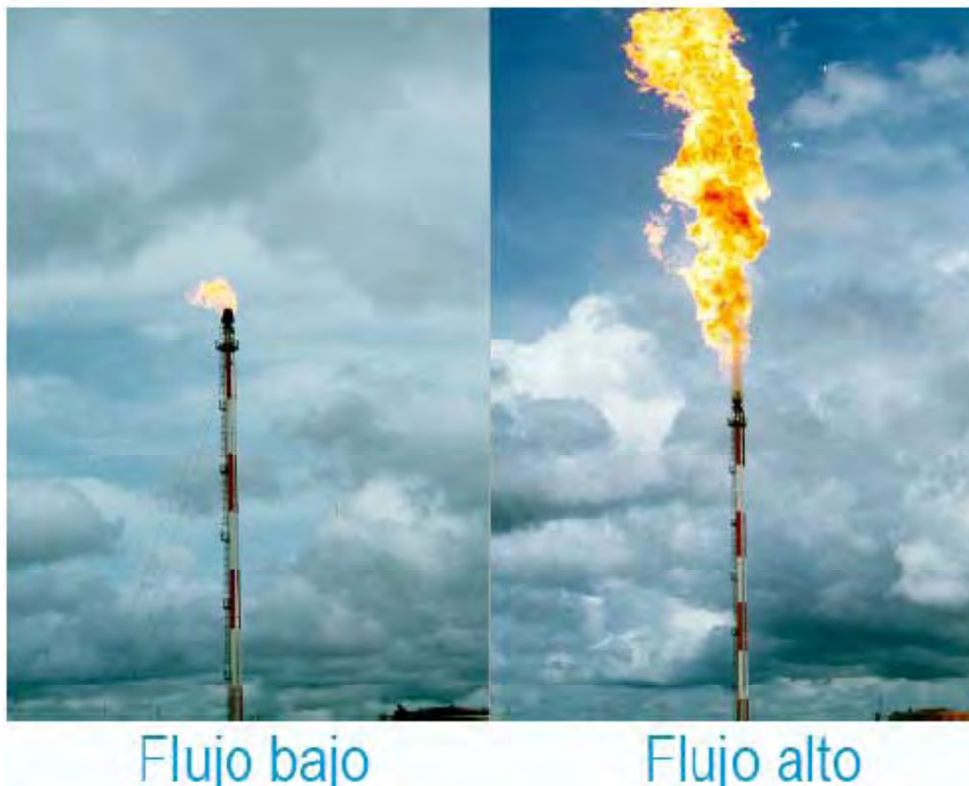
Fotografía 2.9-Quemador de desfogues a fuego alto y bajo.
