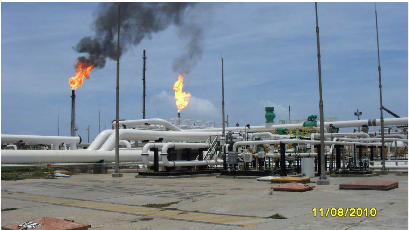
Fotografía 2.1.- Sistema de Desfogue.
