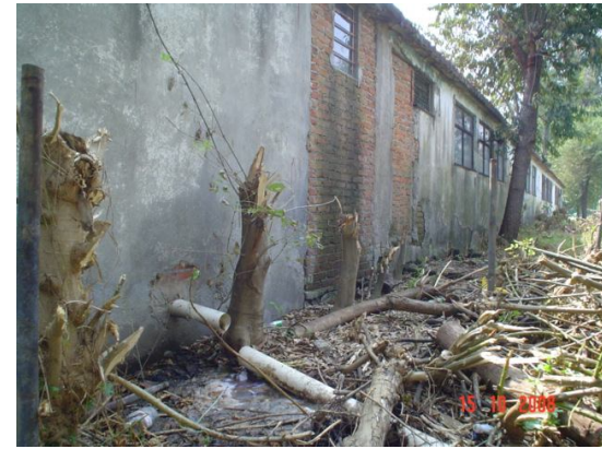
DRENAJE ADJUNTO A LAS AULAS DESCONECTADO
