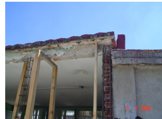
ANCLAJE DE CASTILLOS FUERA DE CUALQUIER ESPECIFICACION
