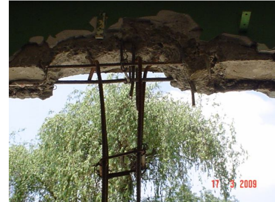
ANCLAJE DE CASTILLOS FUERA DE CUALQUIER ESPECIFICACION
