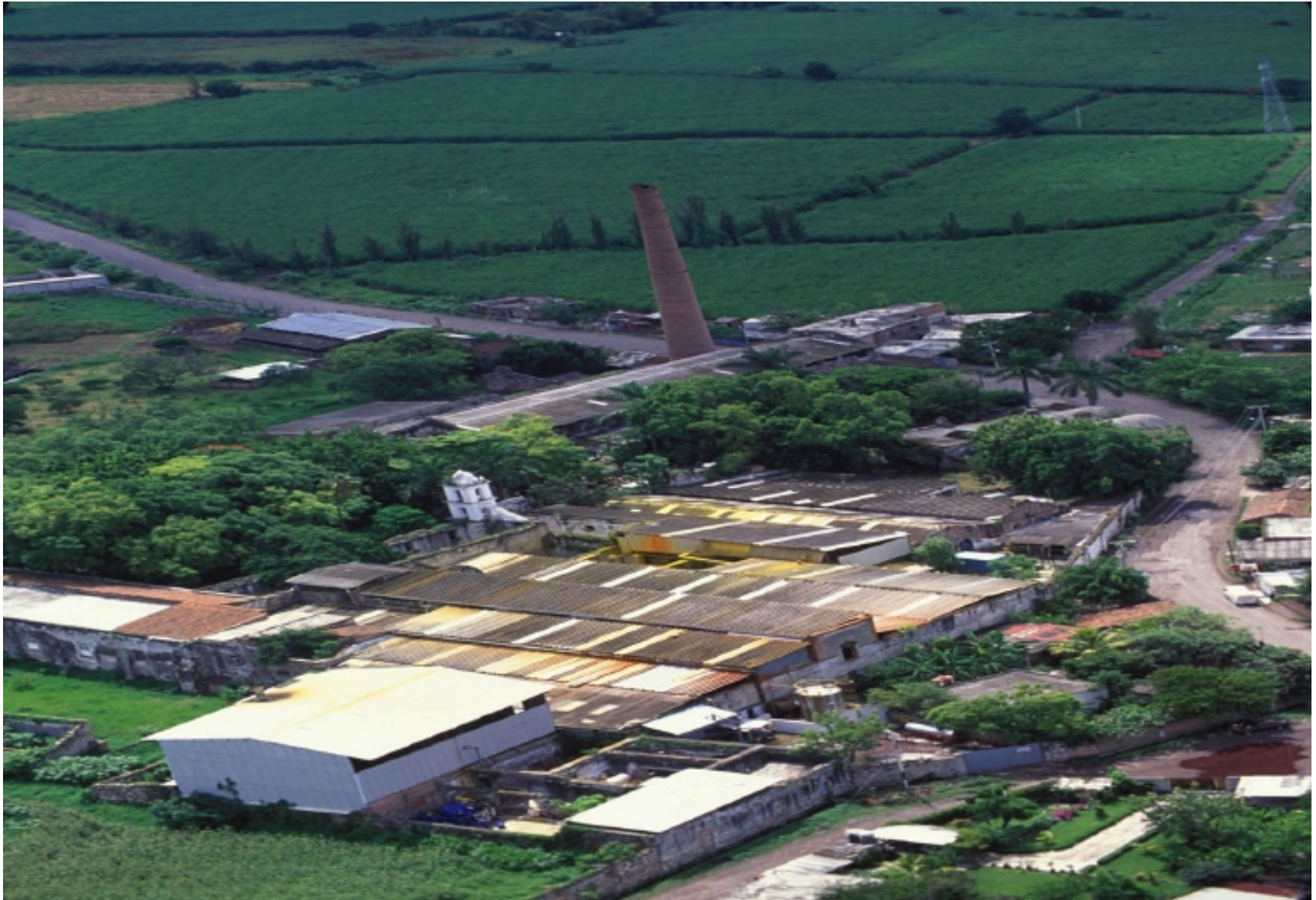
Foto aérea de la exhacienda el Hospital
