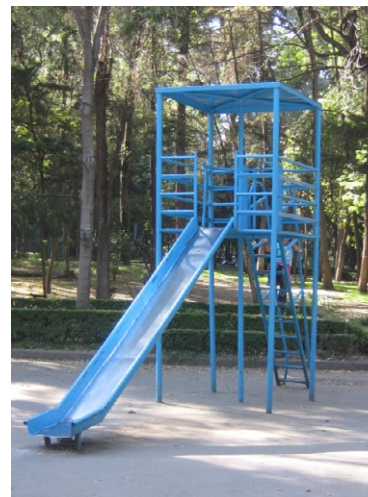
Piso inadecuado de tierra, concreto o piedra que no permiten el amortiguamiento de golpes y caídas.
