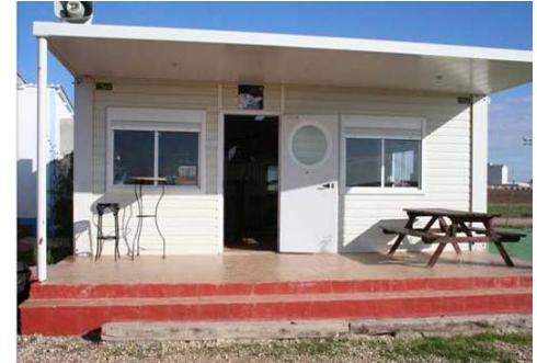
Módulo prefabricado de oficinas móviles
