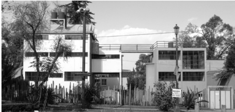
Casas de Altavista, vista sur.
