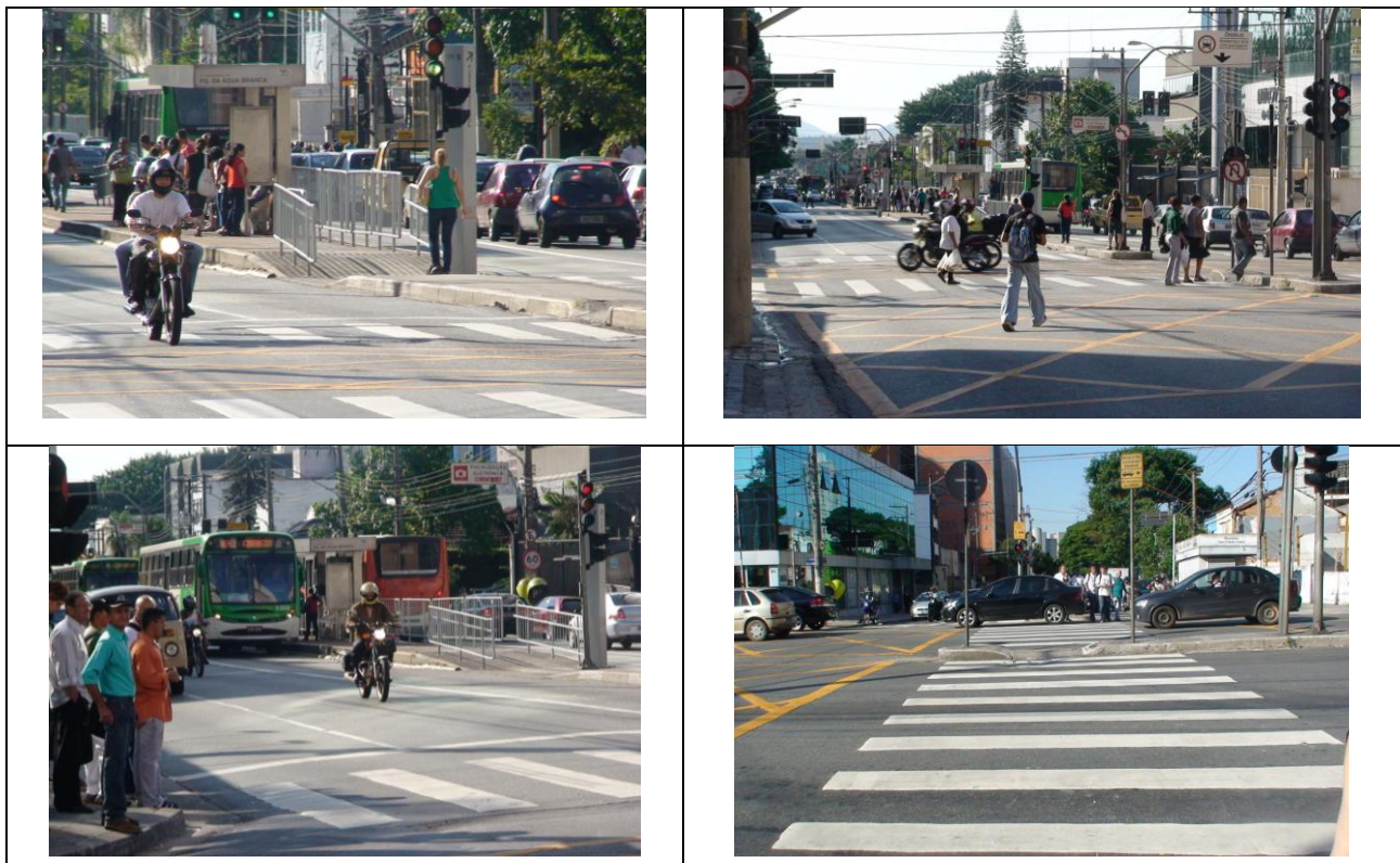
Foto 19: Rampas en Via de Pq. Da Agua Branca; Sao Paolo, 2009. Elaborada por la autora Foto 20: Cruce Peatonal en Via de Pq. Da Agua Branca; Sao Paolo, 2009. Elaborada por la autora Foto 21: Andén de autobús de Pq. Da Agua Branca; Sao Paolo, 2009. Elaborada por la autora Foto 22: Cruce Peatonal en Via de Pq. Da Agua Branca; Sao Paolo, 2009. Elaborada por la autora
