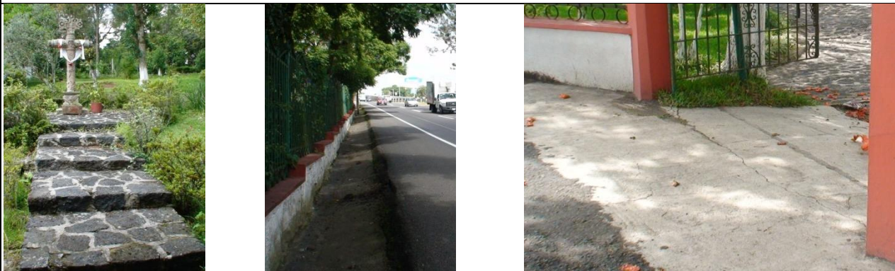
Foto 205, 206 y 207: Pavimentos en el interior y en el exterior de la Estancia Granica. Elaborada por la autora.
