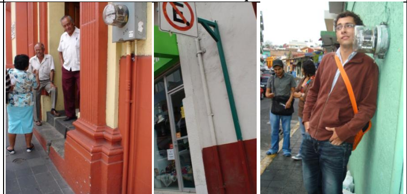
Foto 65, 66 y 67: Elementos que sobresalen de una fachada. Elaborada por la autora.
