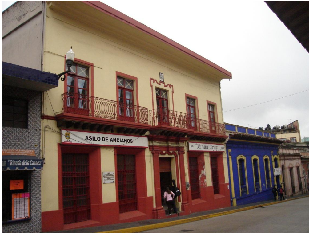
Fachada del Asilo de ancianos “Mariana Sayago”
