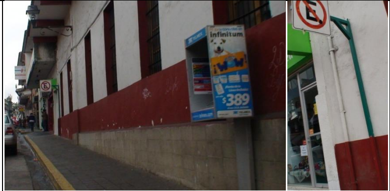
Foto 226 y 227: Elementos que sobresalen de fachadas en calle Xalapeña. Elaborada por la autora.
