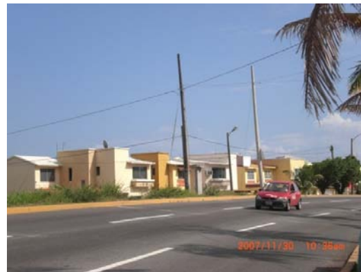
fig.35.vista del fraccionamiento aledaño al terreno.
