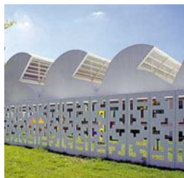
Imagen 37 Extraída con fines didácticos, Pasarela peatonal en Salvador de Bahia (arq. João Figueiras Lima) Paneles y componentes prefabricados en Hospital de la Red Sarah (arq. João Figueiras Lima)
