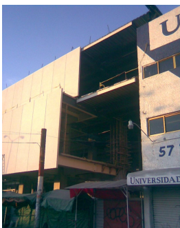
Imagen 24-25-25 Extraída con fines didácticos, Montaje de Elementos Prefabricados, Fapresa. Obra: Parador Azteca
