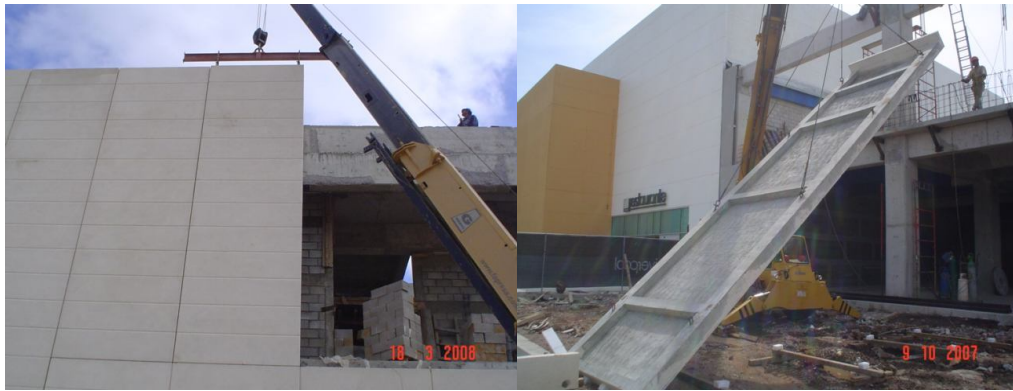
Imagen 16,17 Extraída con fines didácticos, Montaje de Elementos Prefabricados, Fapresa. Obra: Forum Tepic
