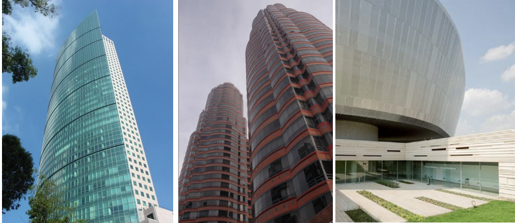
Imagen 3,4,5 extraída con fines didácticos, a).- Torres Gemelas, c).- Torre Mayor, d).-Call Center , http://www.imcyc.com/revistacyt/jul10/arquitectura.htm
