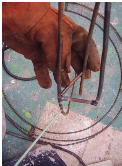
Lámina 126. Soldado de estructura.
