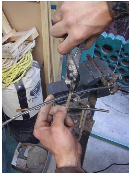
Lámina 124. Definición de longitud de refuerzos Para soldar.
