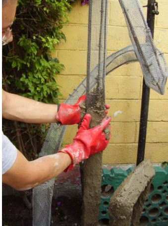
Lámina 137. Cubriendo de concreto utilizando guantes.
