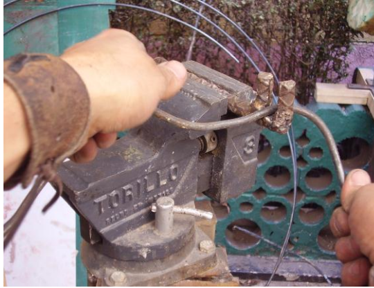
Lámina 121. Doblez de barra de acero de ¼”.
