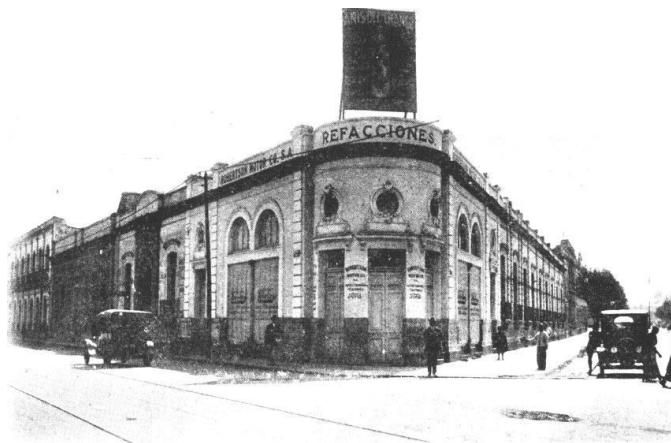
Lámina 17. Primera construcción de concreto armado en la república mexicana. Esquina de artes y París, Ciudad de México.
