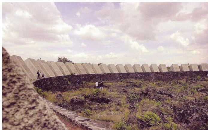
Lámina 71. Espacio Escultórico (120mts. Diámetro exterior, 4mts. De alto, 1979, concreto reforzado y ferrocemento, Ciudad de México).
