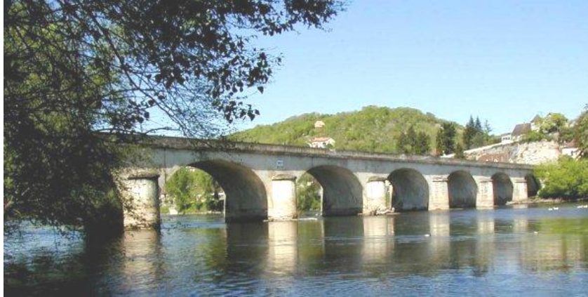
Lámina 10. Pont de Souillac ó Pont Louis Vicat (180mts. de largo, 1824, piedra artificial, Souillac).
