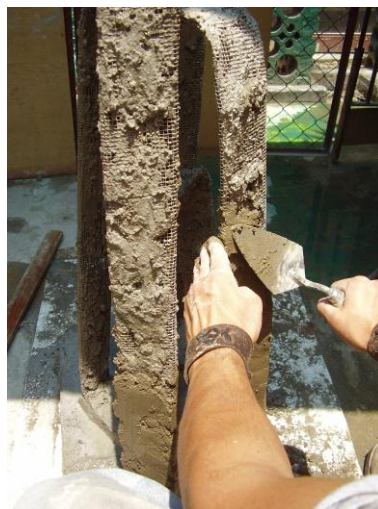
Lámina 136. Cubriendo de concreto utilizando cuchara de albañil.
