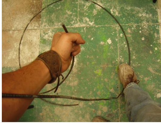
Lámina 115. Doblez de barra de acero de ¼”.
