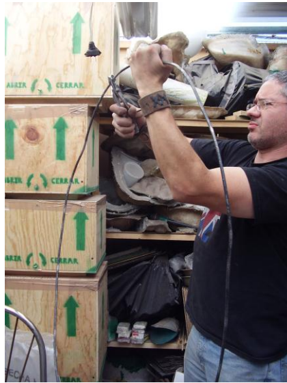
Lámina 116. Doblez de barra de acero de ¼”.
