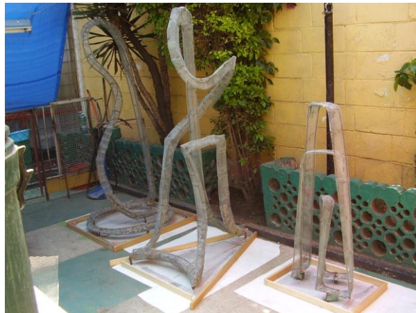
Lámina 133. Piezas listas para recibir Cubierta de concreto.
