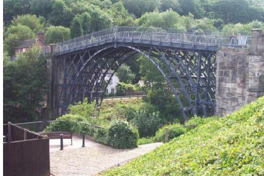
Lámina 4. Puente Coalbrookdale (43mts. Largo, 1799, hierro colado, Shropshire).
