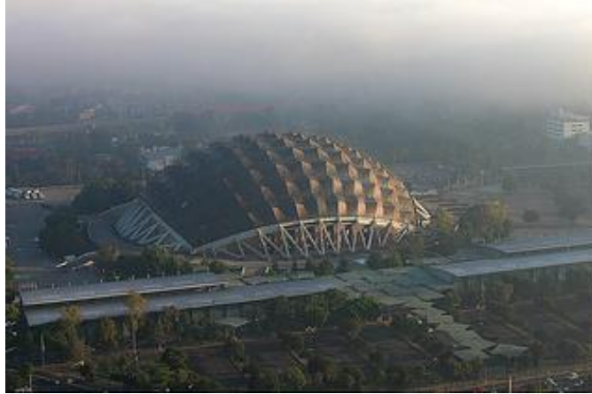
Lámina 81. Felix Candela “El Palacio de los Deportes” (1968, concreto reforzado y ferrocemento, Ciudad de México).
