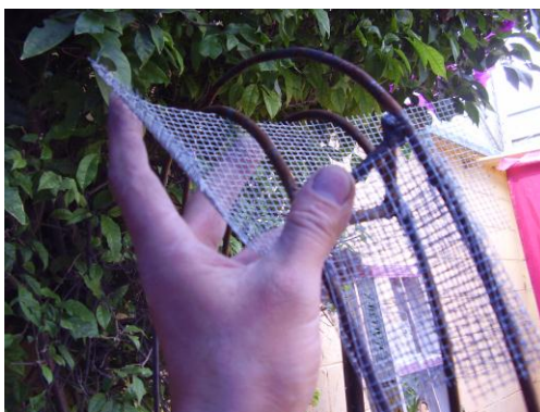
Lámina 131. Forrado de malla de acero.
