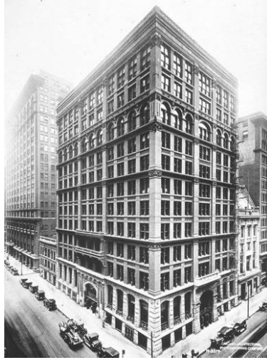
Lámina 5. Edificio de la Home Insurance Company de Chicago (54.9mts., Construido en 1885, Demolido en 1931, acero estructural, Chicago).
