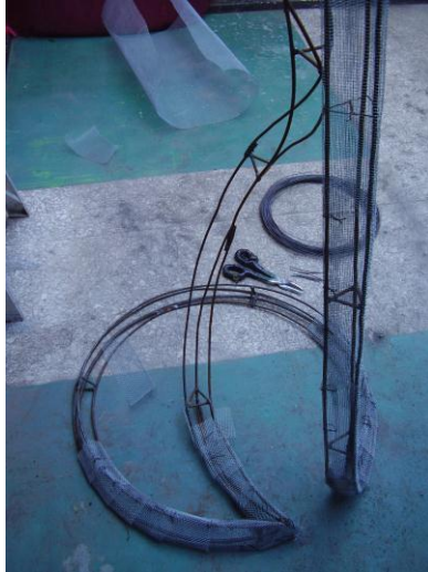
Lámina 132. Forrado con malla en progreso.
