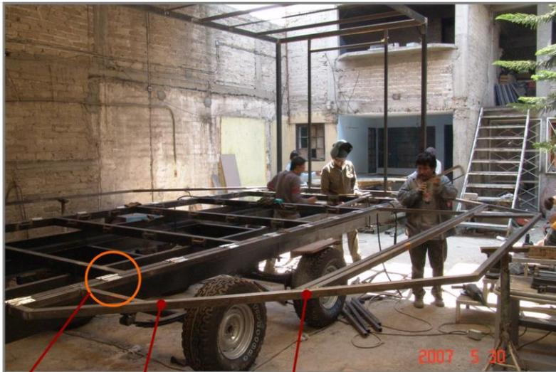
Bisagra de acero con perno de 1/4" y placa de 1/8" con unión de soldadura por arco .
