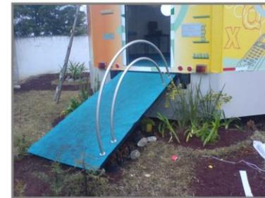
Tubo de acero inoxidable de 2" de diámetro rolado en frío con radio de 1.20m .
