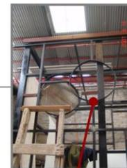
Ptr de 1" con uniones de soldadura de arco manual.
