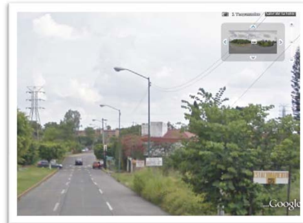
Alumbrado Público con cableado aéreo
