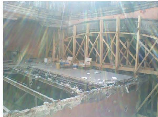
Imagen 21. Demolición de la losa.
