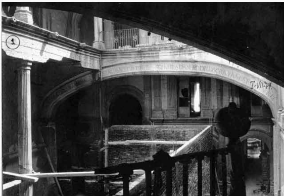
Imagen 20. Foto 1950, proceso de construcción de la losa
