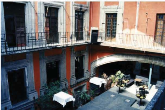
Imagen 22. En esta foto se observa la losa de concreto como estaba, esto hacía gran diferencia en el espacio, aparentemente era muy pequeño, además que rompía con todo diseño y proporción del mismo, Podemos observar cómo pasa entre el arco.
