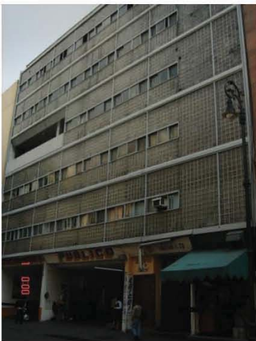
Imagen 40. Fachada del estacionamiento.
