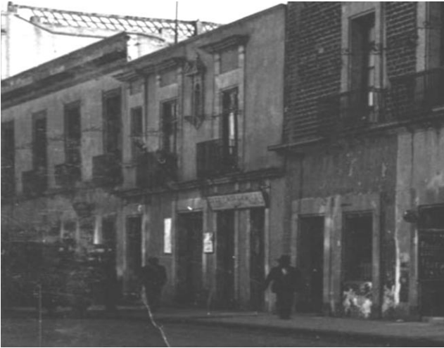
Detalle de Fotografía de 1935 del inmueble ubicado en Mesones 93. (Fototeca del INAH)
