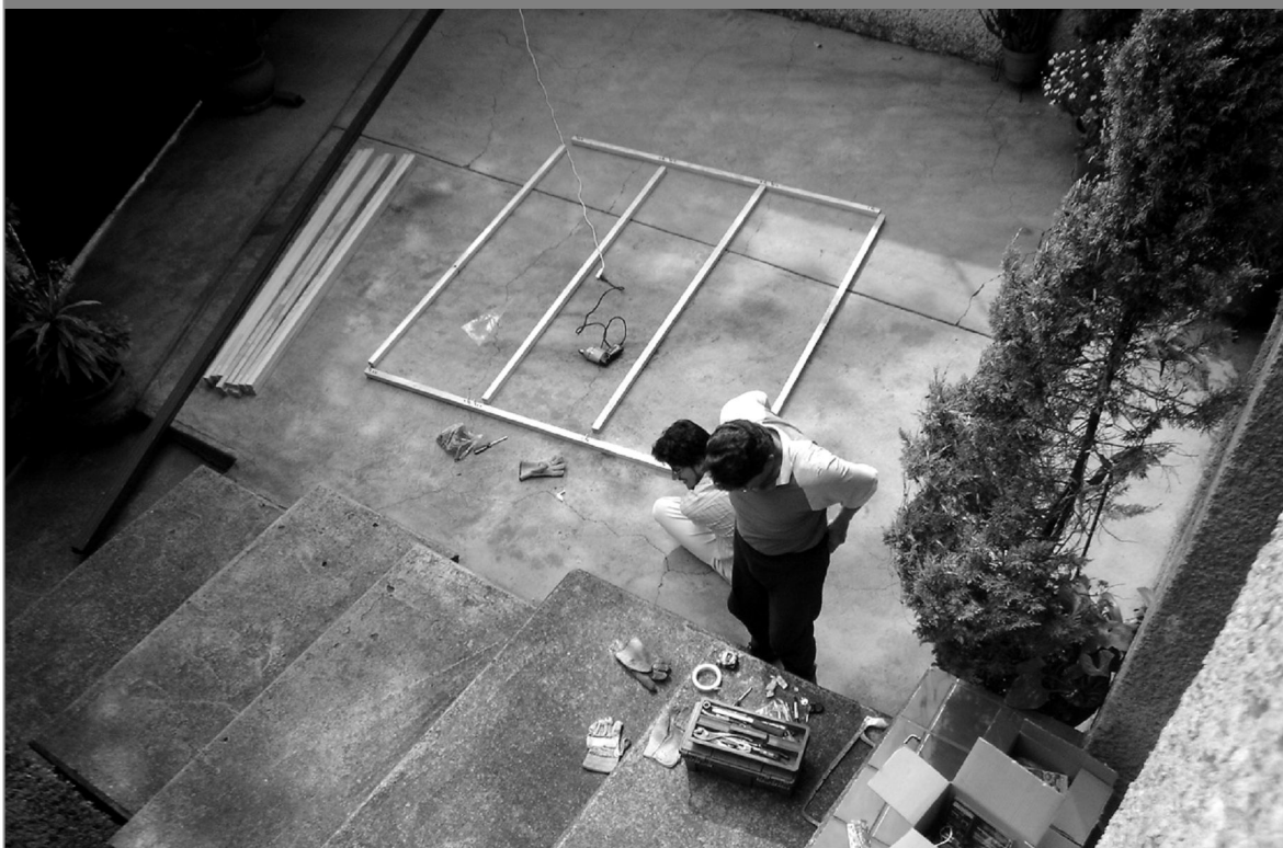
Imagen 21: Construcción del invernadero. Diciembre de 2009.
