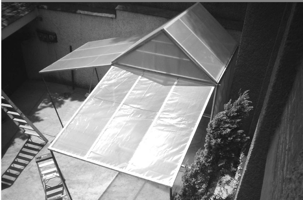
Imagen 29: Construcción del invernadero. Aplicación del techo. Abril de 2010.
