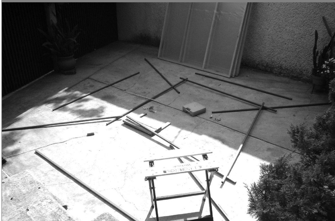
Imagen 26: Construcción de la estructura de hierro. Febrero de 2010.
