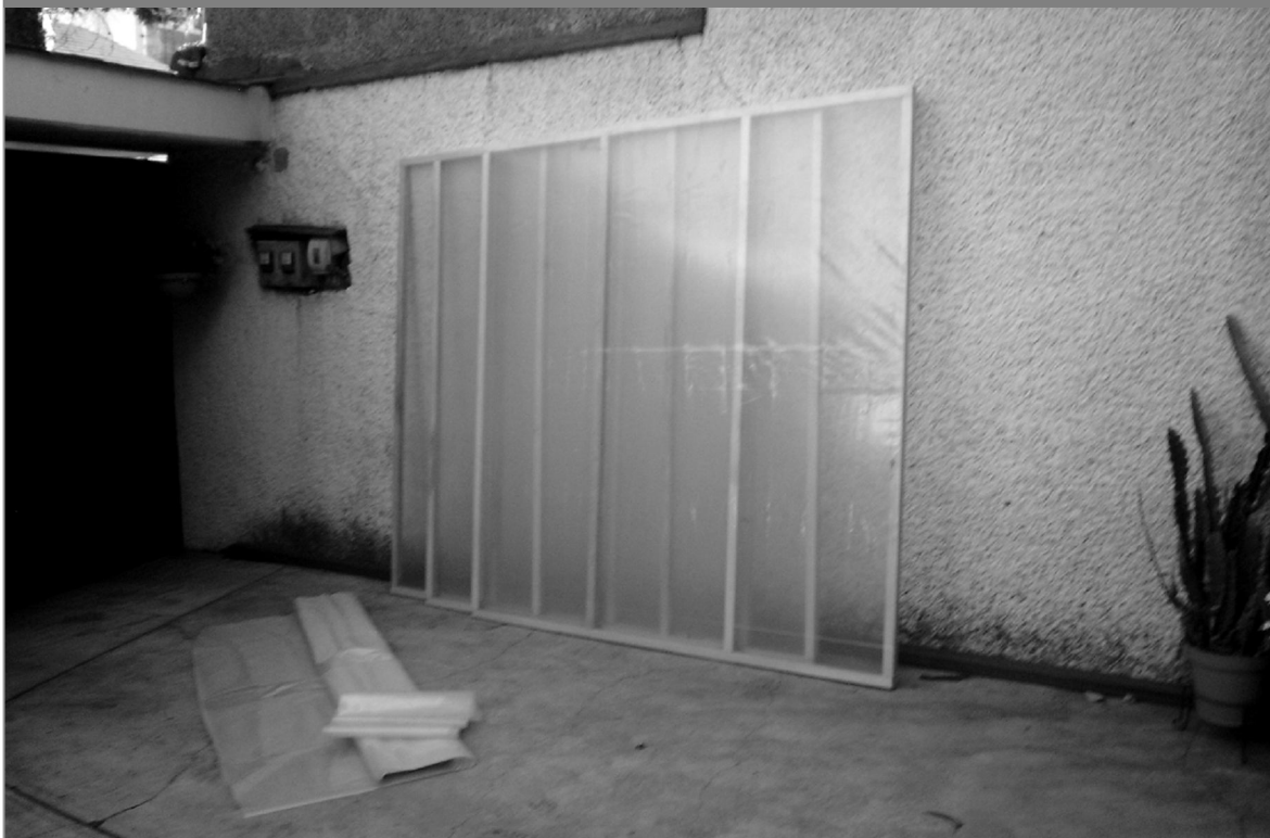
Imagen 23: Construcción del invernadero, aplicación del plástico en los paneles. Enero de 2010.
