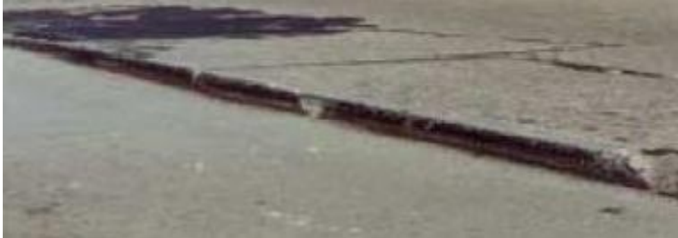
Figura 4.3 Desplazamientos verticales diferenciales.
