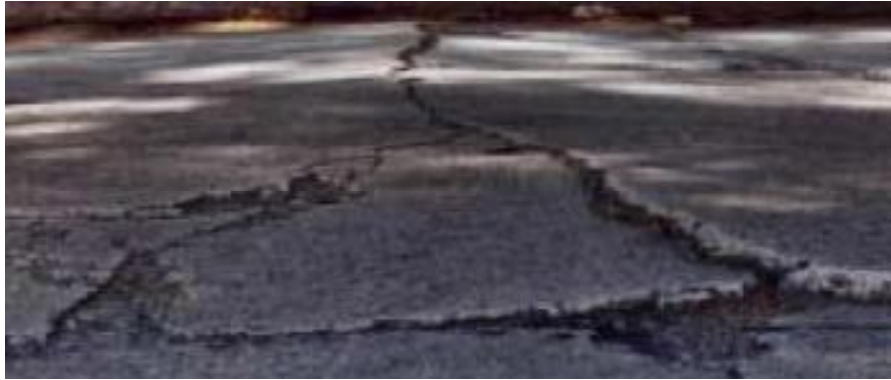
Figura 4.1. Levantamiento de losas.
