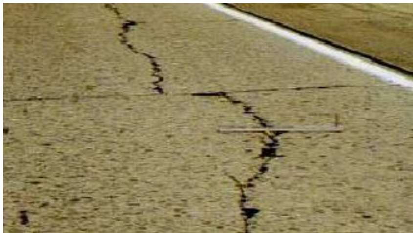
Figura 4.5 Fisura longitudinal
