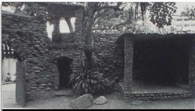
Vista interna de la entrada del castillete de Armando Reverón en Macuto. s/f Fotografía: Humberto Febres Cordido.
