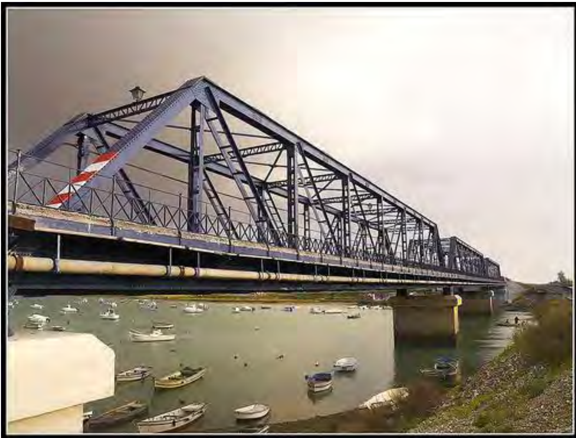
Puente de Armadura.
