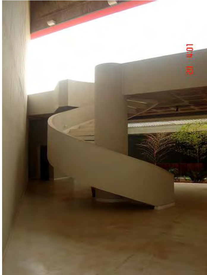
Escalera de caracol al interior.
