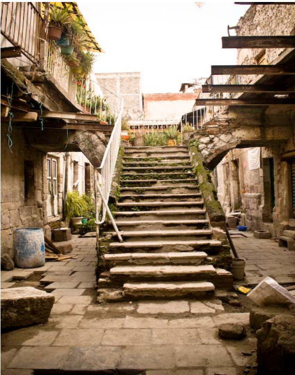
Vecindad ruinososa en el centro de la ciudad. (2008).
