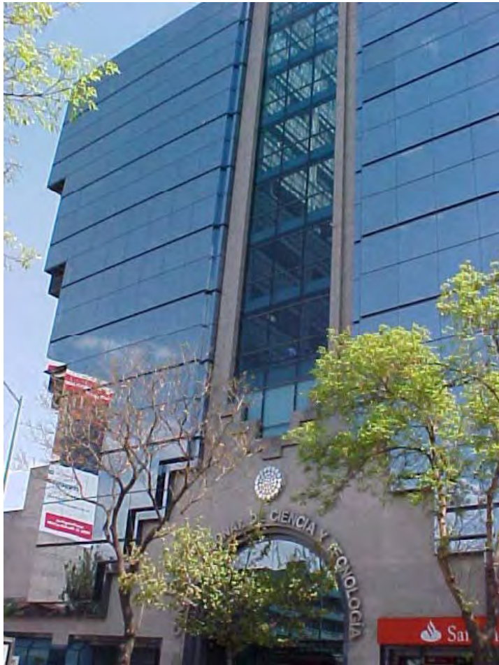
Edificio Ciencia y Tecnología
