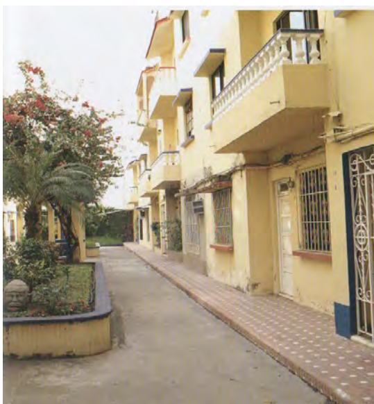
42 Edificio Pujol, ca. 1940
