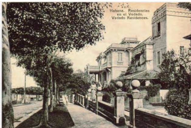
135 Residencias en El Vedado, ca. 1930 Imagen tomada del libro Hemingway en Cuba
