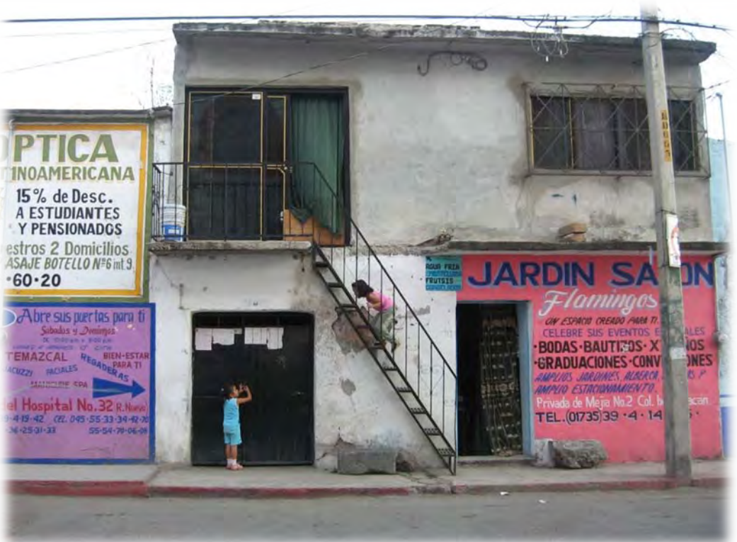
IMAGEN 42. Comercio localizado en la calle. No existe una imagen urbana determinada lo que provoca contaminación visual. FUENTE Fotografía propia.
