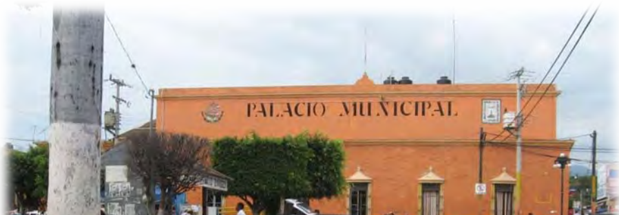
IMAGEN 27. Fachada principal. FUENTE Fotografía propia.
