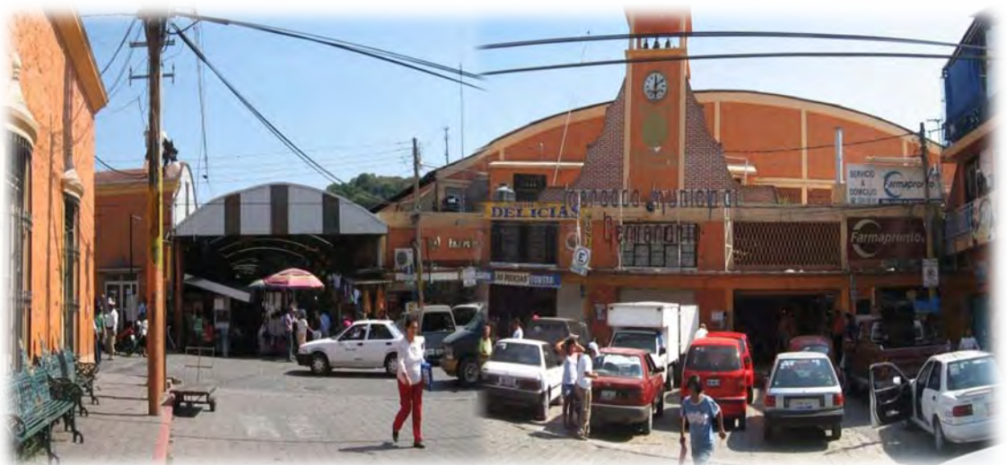
IMAGEN 32. Fachada principal del Mercado Centenario. A de lado izquierdo se observa el acceso al Pasaje Escalante. FUENTE Fotografía propia.
