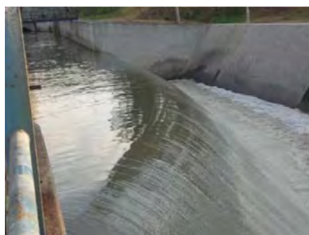
Fig. 2.5 Vertedor de Excedencias
