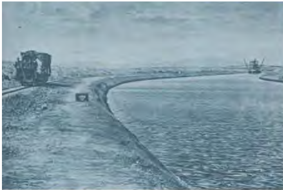
Fig. 1.6 Gran canal del Desagüe
