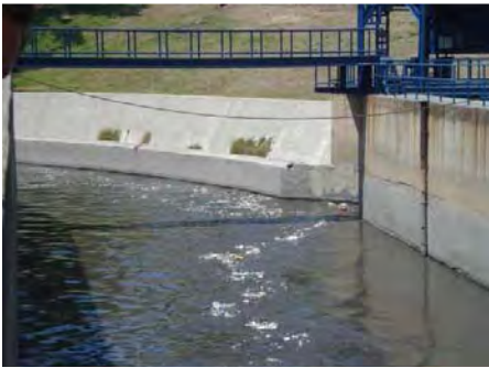
Fig. 2.6 Canal de Toma en Curva
