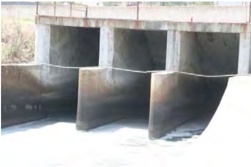
Fig. 2.8 Túnel alcantarilla bajo el río el Salto
