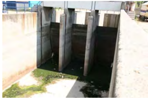
Fig. 2.7 Estructura de Control
