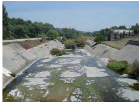
Fig. 2.9 Rectificación del Río el Salto
