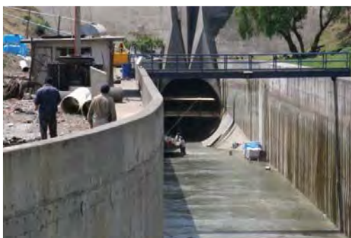
Fig. 2.2 Portal de Salida
