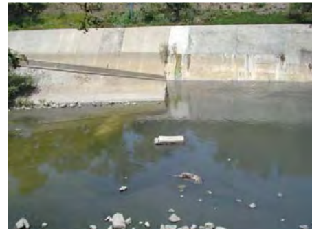
Fig. 2.11 Zona de Confluencia
