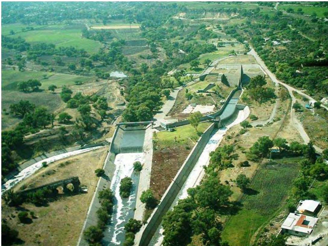
Fig. 2.1 Obra derivadora del Túnel Emisor Central
