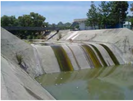
Fig. 2.10 Tanque amortiguador del Río el Salto
