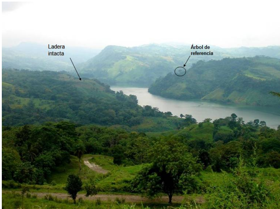
Figura 2.10. Vista del sitio del deslizamiento días antes. Cortesía CPH-CFE.
