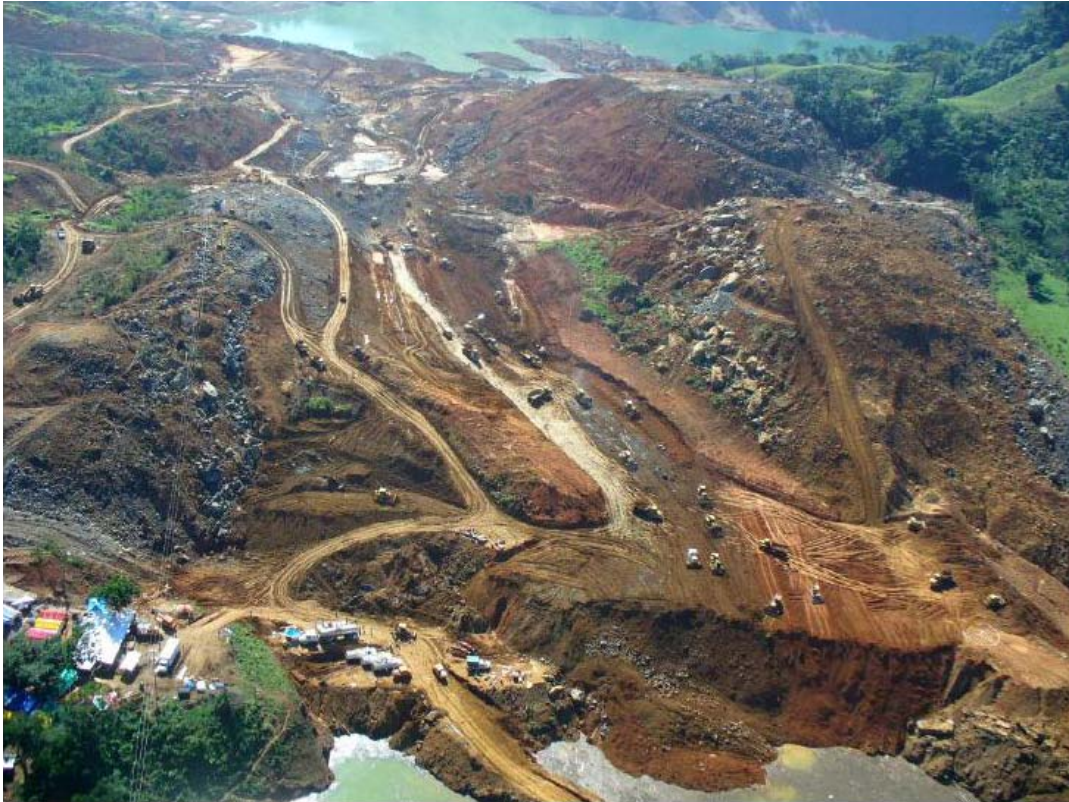
Figura 2.9. Trabajos de excavación. Cortesía CPH-CFE.
