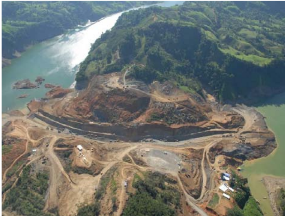
Figura 2.14. Panorámica Aérea del Canal 16-dic-2007. Cortesía CPH-CFE.
