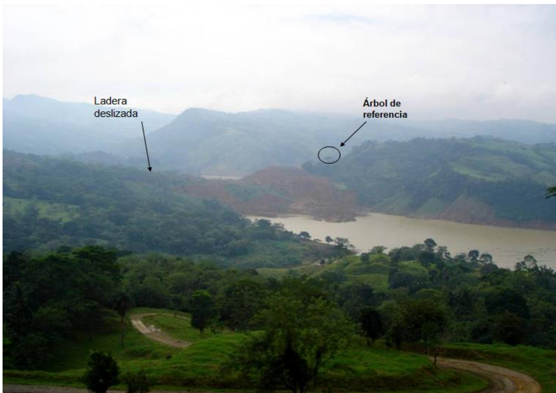
Figura 2.11. Vista del sitio del deslizamiento días después. Cortesía CPH-CFE.
