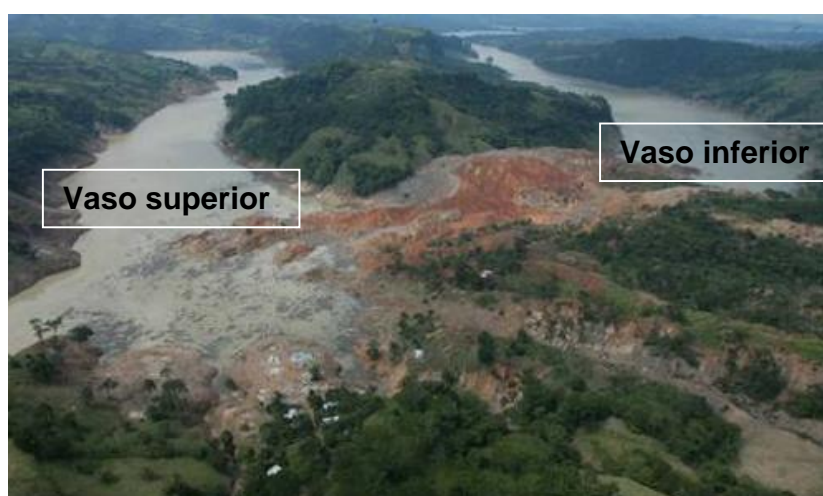
Figura 2.8. Zona del deslizamiento entre aguas arriba y aguas abajo. Cortesía CPH-CFE.
