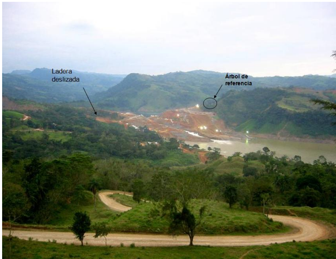
Figura 2.12. Vista del sitio del deslizamiento con el canal operando. Cortesía CPH-CFE.
