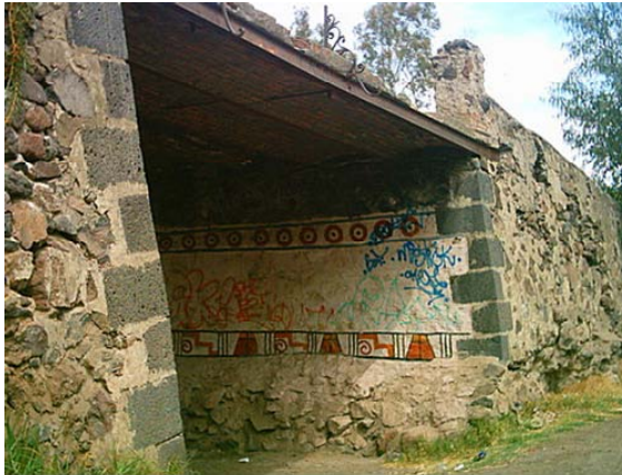
Vista actual del Puente de Urrutia.
