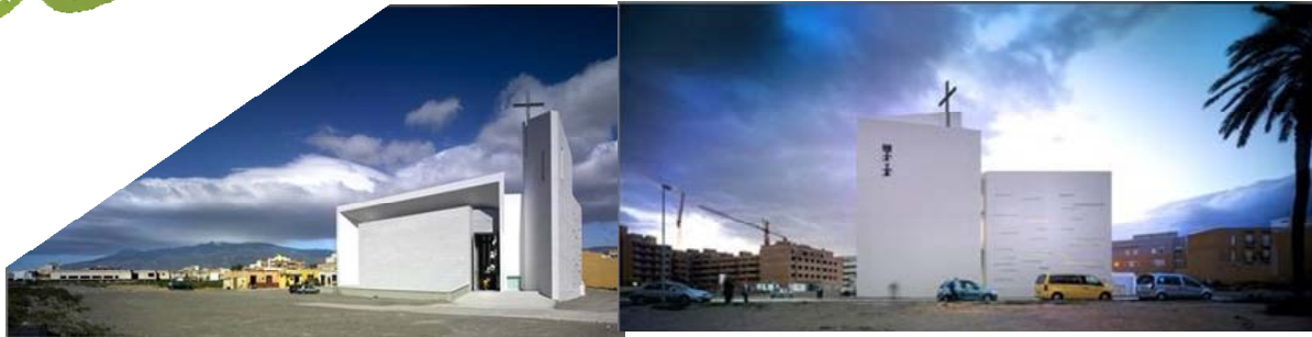
Vistas de las Fachadas
