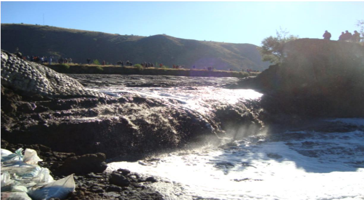
Figura 4.1.- Vista de la falla del bordo en el río la Compañía
