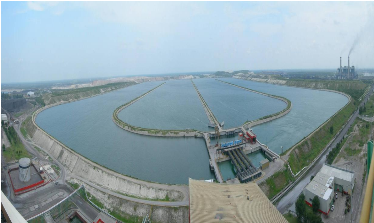
Figura 4.5.- Vista general del estanque de la termoeléctrica y los bordes
