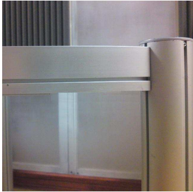
Figura 3.4. Ensamble entre perfil horizontal curvo y perfil redondo con tenso chapa.
