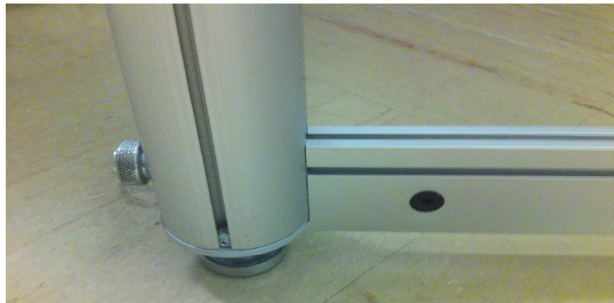
Figura 3.1. Unión entre perfil horizontal y perfil redondo.
