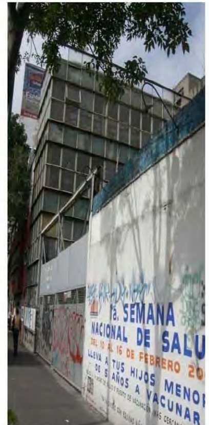
Edificio que se va a demoler
