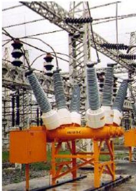
**Fig. 1.44 Interruptor tipo soplo en SF<sub>6</sub>, tanque muerto, marca Alstom, tipo DT1-145F1 de 145 kV, 2000 A, 40 kA de capacidad interruptiva con mecanismo de resorte.**
