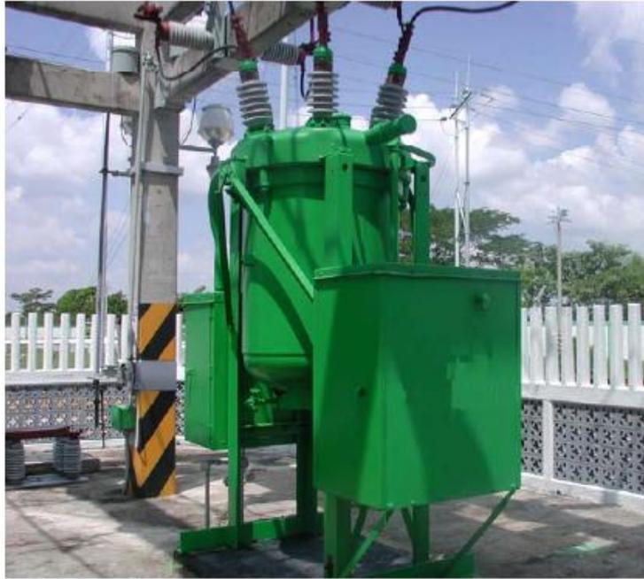
**Fig. 1.36 Interruptor trifásico en gran volumen de aceite con un solo tanque clase 34.5 kV.**
