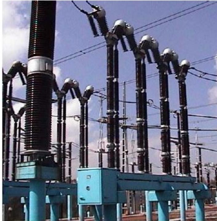
**Fig. 1.39 Interruptor en pequeño volumen de aceite marca Sprecher & Schuh de 115 Kv con mecanismo de resorte.**
