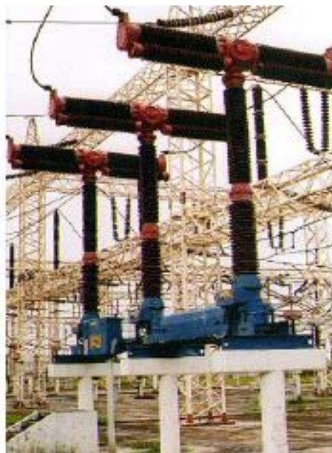
**Fig. 1.43 Interruptor tipo sopro en SF6, tanque vivo, marca IMEX, tipo 3AS2, 245 kV, 2000 A y 40 kA de capacidad interruptiva con mecanismo hidráulico.**
