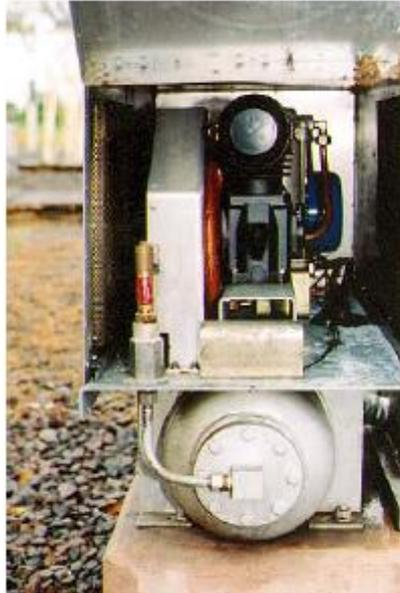
Fig. 1.56 Mecanismo neumático para un interruptor de SF6, clase 125 kV.
