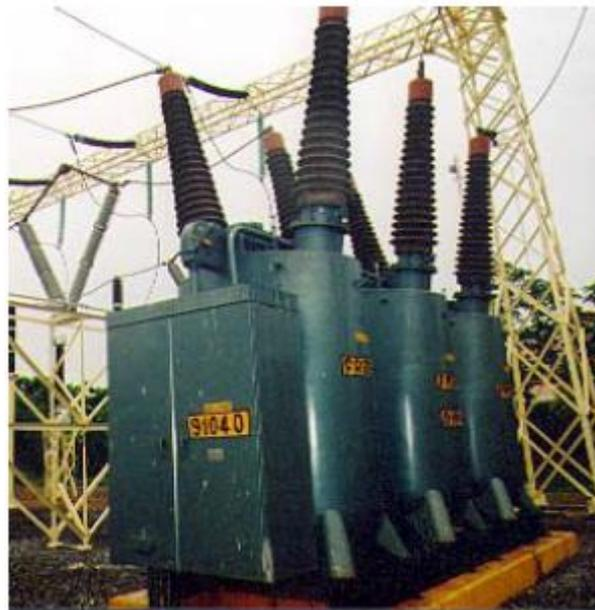
**Fig. 1.37 Interruptor trifásico en gran volumen de aceite con un tanque por polo. Marca Westinghouse, tipo 242GW40, clase 242 kV, 1600 A y 40 kA de capacidad interruptiva y mecanismo neumático.**
