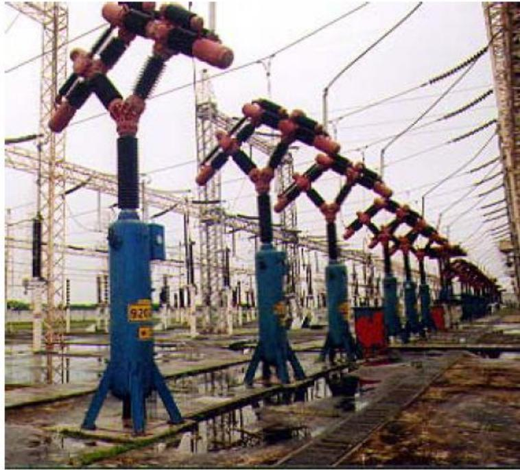
**Fig. 1.33 Interruptor de soplo de aire. marca Brown & Boveri, mecanismo neumático, 245 kV, 2000 A y 40 kA de capacidad interruptiva.**
