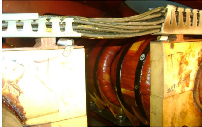
Figura 4. Transformadores de corriente de una fase del generador
