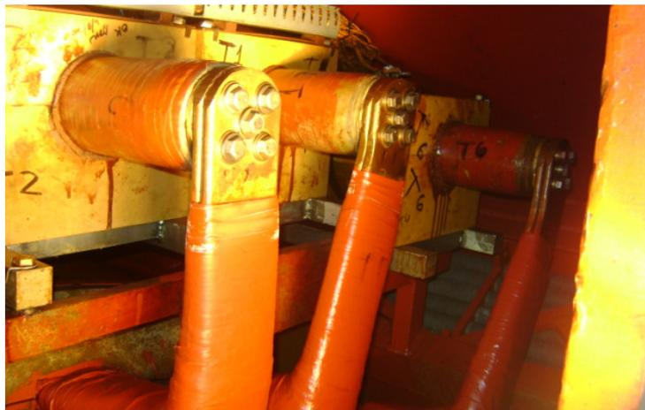
Figura 3. Bornes de conexión del devanado de un generador
