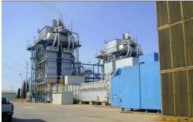
Figura 3. Recuperador de calor
