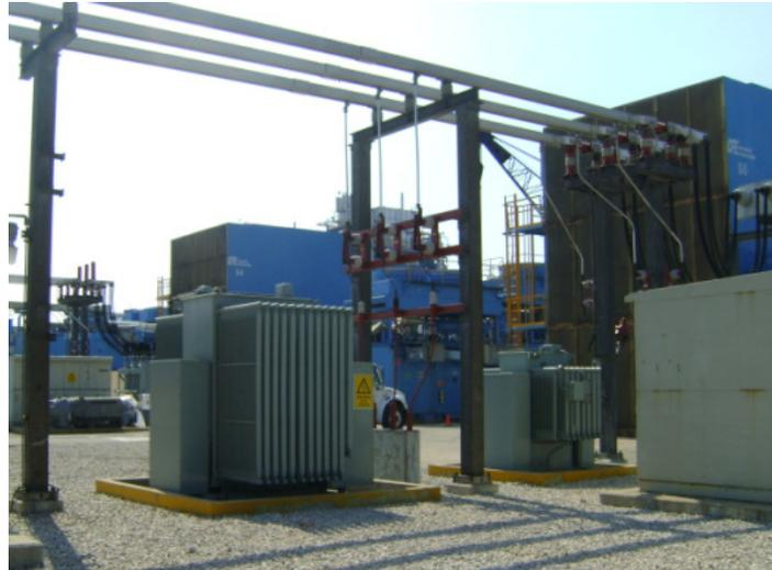
Figura 11. Transformador auxiliar
