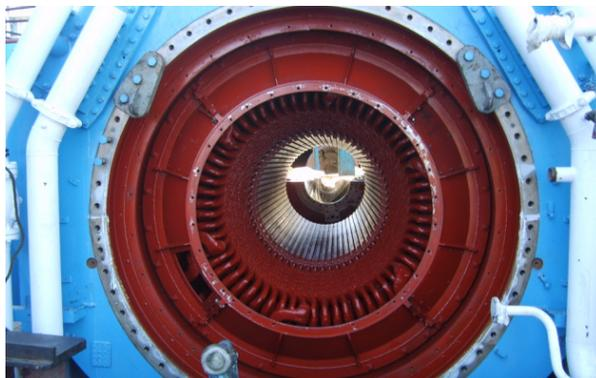
Figura 24b. Vista del estator del generador
