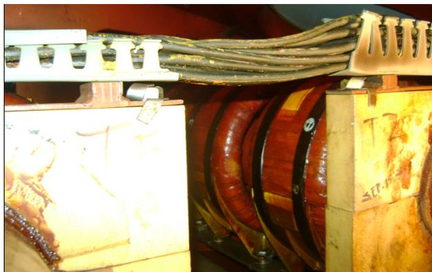
Figura 1. Transformadores de corriente
