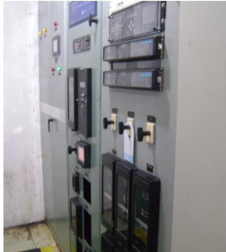
Figura 1. Modulo de relevadores de protección para un generador
