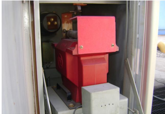
Figura 5. Transformador de potencial
