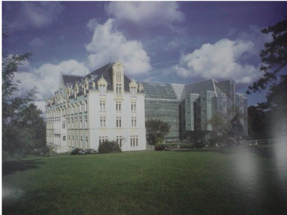
Imagen 29. Vista hacia fachada principal mostrando la integración y traducción de todos los elementos del antiguo edificio.
