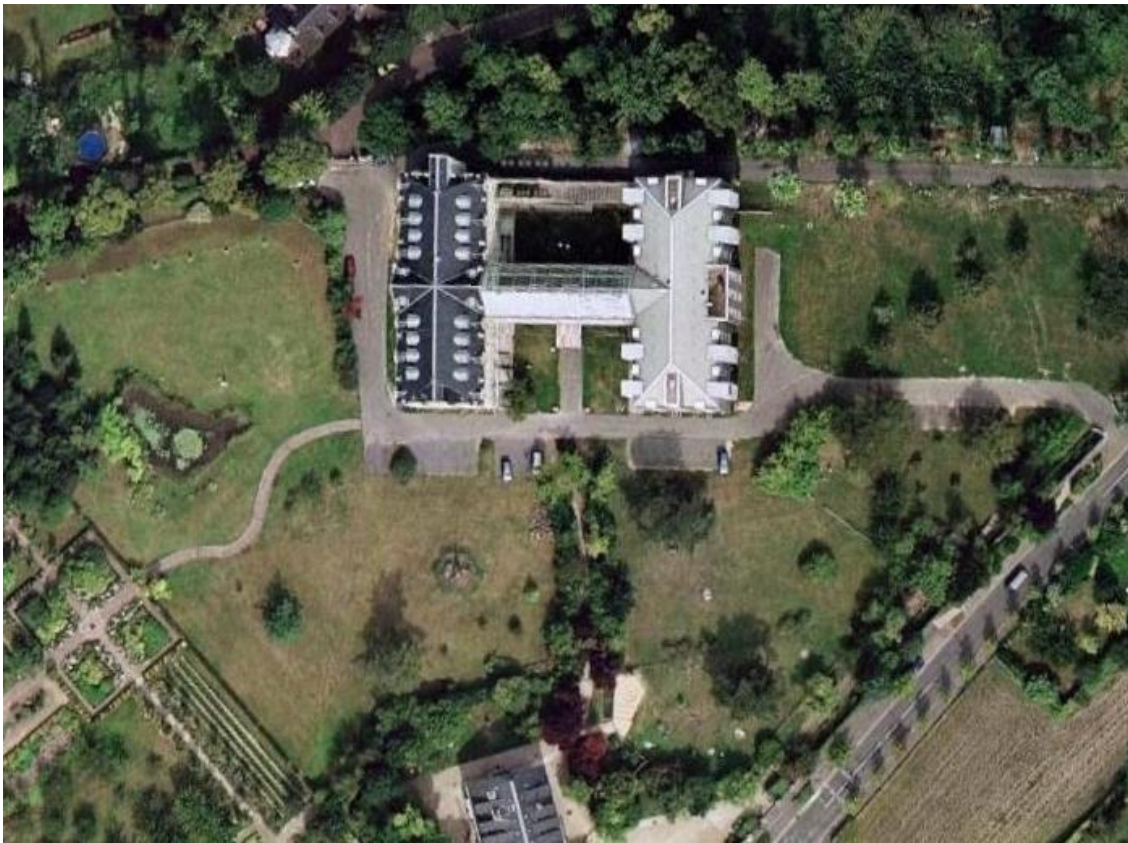
Imagen 27. Vista Área del Edificio y su entorno.
