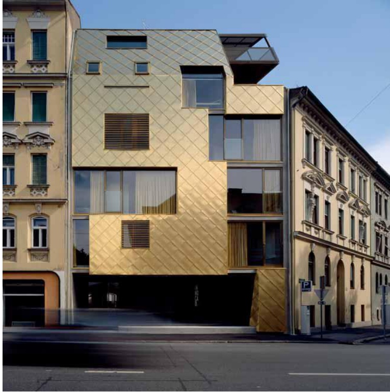
Imagen 18. Vista de Fachada principal.
