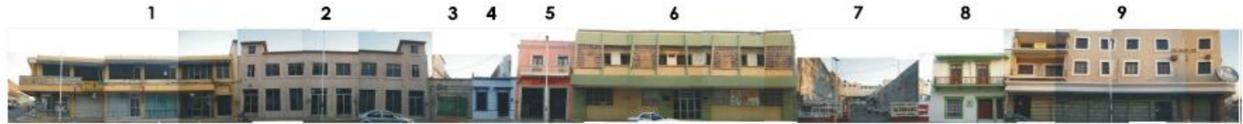
FACHADA EMPARAM LADO NORTE
