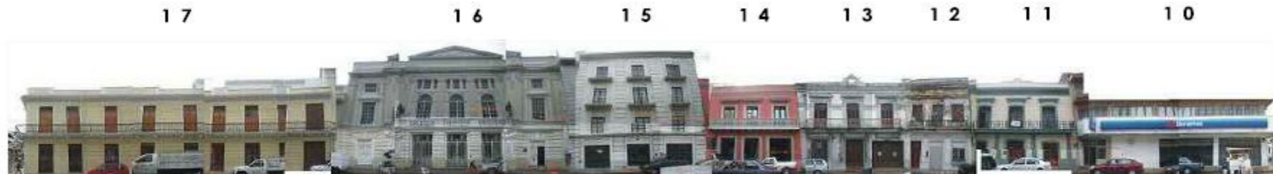
FACHADA EMPARAM LADO SUR
