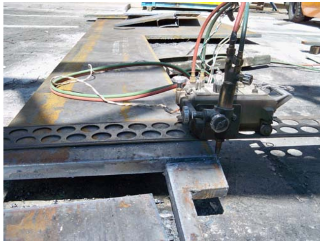
Fig. IV.3 Corte de placa por medio de un carro automatizado y soplete.
