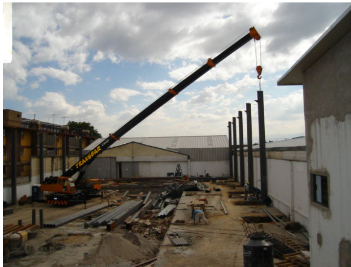
Fig. V.1 Montaje con grúa.
