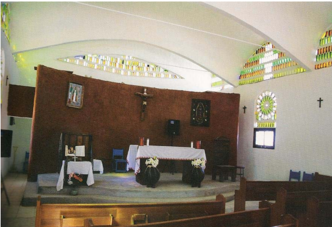
Im. 44. Interior, Iglesia Kobishi Teopa. Ventanales de botellas “como vitrales de iglesia antigua”, al fondo el ojo de pescado o Vésica el “ojo de Dios” requirió para su realización 700 botellas.
