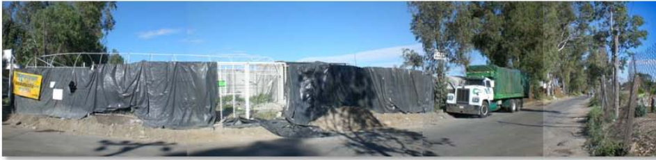
1.- Acceso por Calle Puente Urrutia. –Barrera física-
