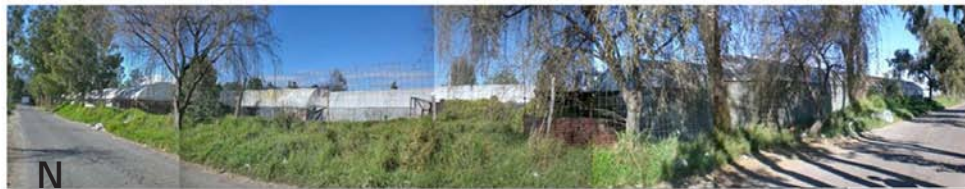
2.- Vista desde la Calle Puente Urrutia – Porosidad-
