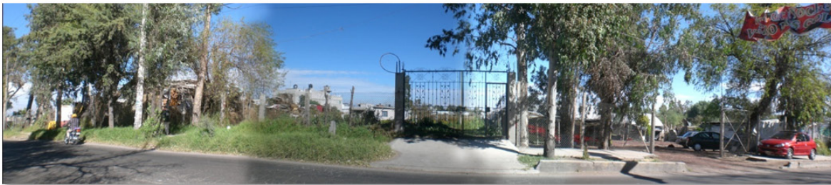
15.- Deshuesadero sobre Av. Nuevo León –Barrera visual y permeabilidad-
