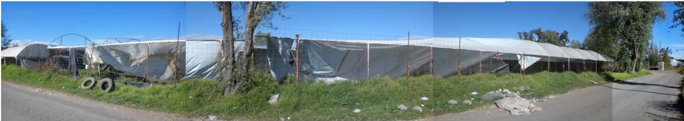
4.- Vista al terreno colindante sobre la Calle Puente Urrutia – Permeabilidad-
