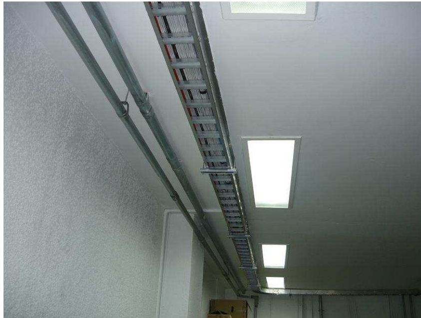
Imagen 3.10 Sistema de cableado estructurado tipo horizontal
