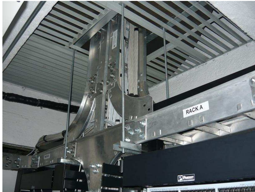
Imagen 3.11 Cableado vertical
