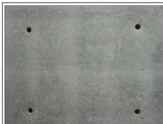
Figura N°53. Imagen que ilustra una eficiencia en la regularidad de los tensores que forman parte del acabado de las superficies del material aparente.
