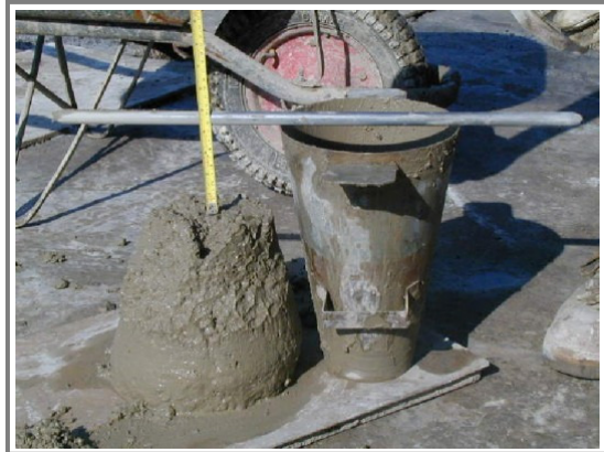
Figura N°20. Prueba de revenimiento. Luego de llenado y compactado con una varilla en tres fases el cono de revenimiento con la mezcla, se levanta cuidadosamente y se coloca al revés tomando en seguida varias mediciones que arrojarán las tolerancias admisibles.
