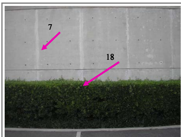
Figura N°97. Defecto 7 líneas entre capas y defectos 18 desgastes inusitados por cultivos biológicos.
