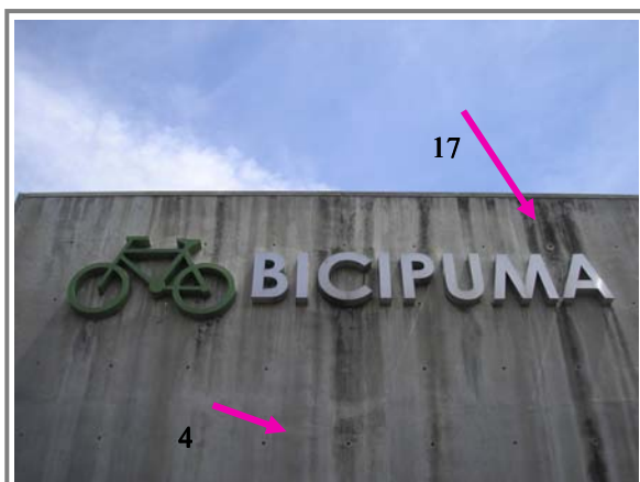
Figura N°102. Defecto 4 variación de color y 17 suciedad.
