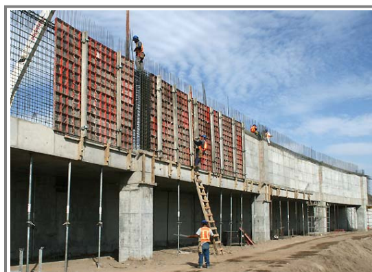
Figura N°46. Instalaciones de Moldajes de una envolvente arquitectónica.
