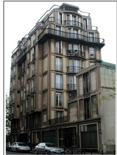
Figura N°4. El primer edificio con estructura de concreto armado, Auguste Perret (1903). Francia.
