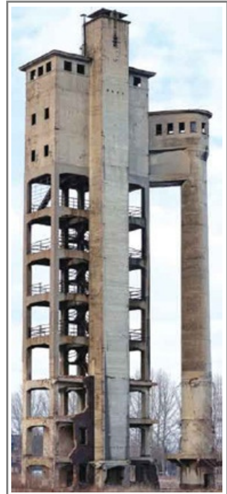
Fig. N°29. Imagen de estructura industrial papelera, para ser reconvertida, con otro uso pero guardando la calidad con la que fue creada.
