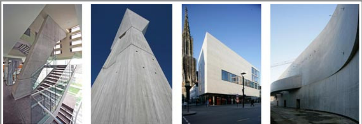
Figura N°30. Imágenes de superficies diseñadas con diversas formas arquitectónicas edificadas de concreto aparente.
