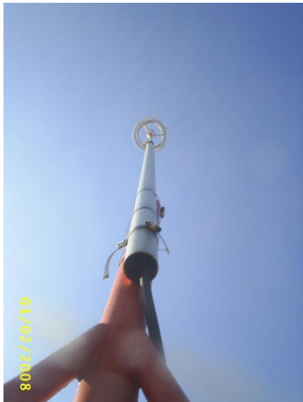
Pararrayos y mástil. Ambos se encuentran en buen estado.
