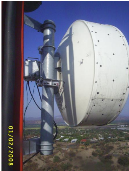
Soportes de Microondas. Se encuentran en buen estado.
