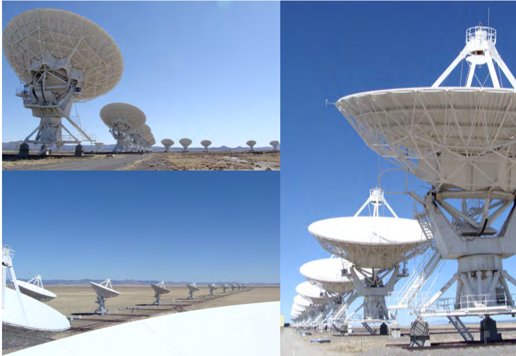
Figura 3.1: Varias fotografías del interferómetro Very Large Array en su configuración D, la mas compacta. El instrumento fue puesto en funcionamiento en 1980. Se puede apreciar lo juntas que están las antenas en esta configuración. Arriba a la izquierda se ve parte de los tres brazos del arreglo; abajo se ve la extensión de éstos con respecto al horizonte; a la derecha se nota la estructura mecánica de las antenas.
