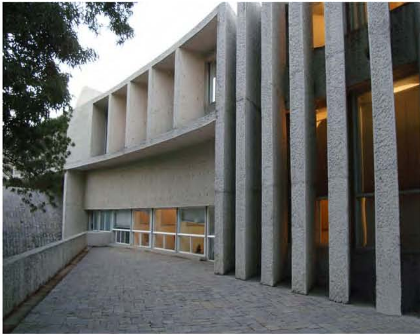
Vista desde el patio hacia las oficinas donde se puede apreciar el uso de parte-soles que evitan la entrada directa de la luz del sur.
