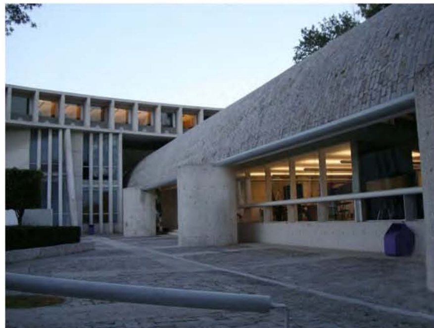
Vista desde el patio principal el cual da acceso a todos los espacios del Conservatorio.
