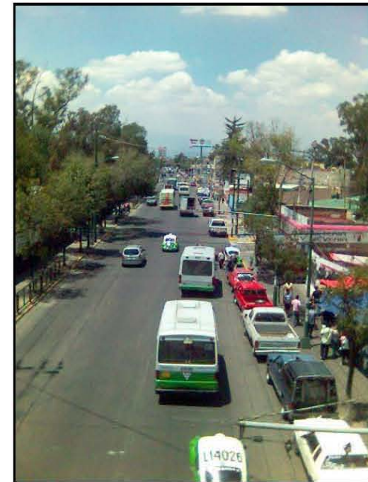
Foto 28 y 29. Vista de la Calzada Ermita Iztapalapa en sentido oriente - poniente
