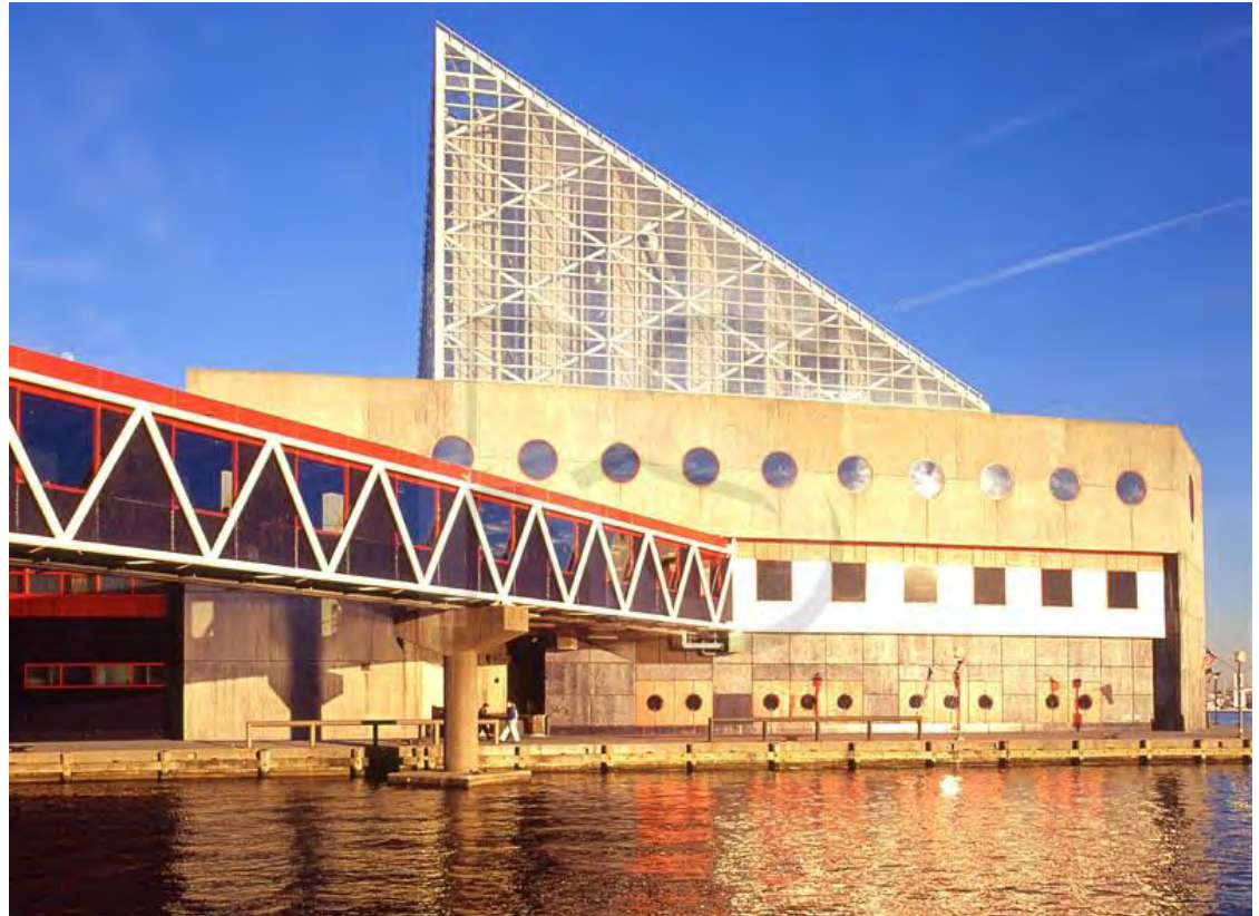
Vista exterior del Acuario de Baltimore
