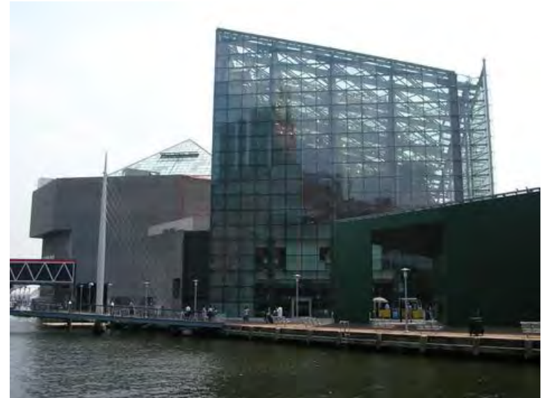
Vista exterior del Acuario de Baltimore
