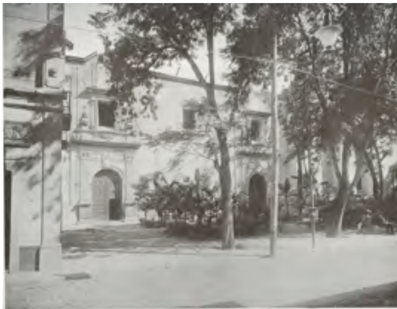
Iglesia de Santa Clara en la ciudad de Querétaro. Fachada Toma General
