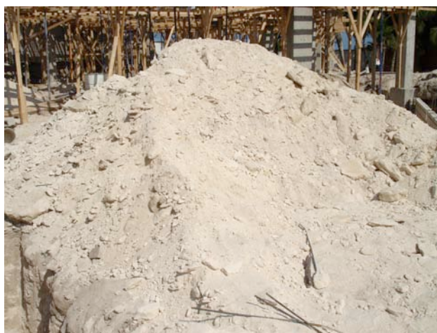
Sascab Extraído de la excavación de la zapata superior
