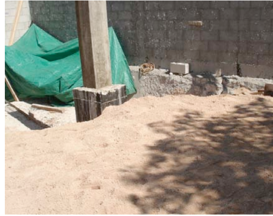
Figura 6. Relleno compactado de la cimentación
