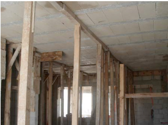
Figura 6. Sistema de piso (viguetas y bóveda)
