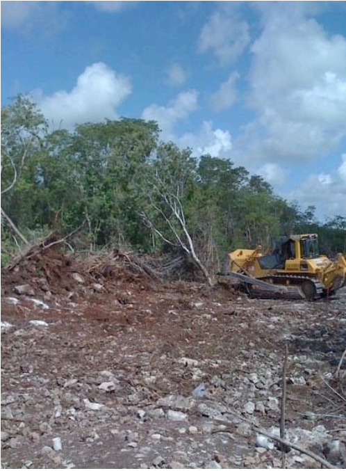
Fig.2 Despalme del terreno
