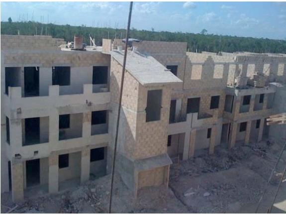
Fig. 6 Estructura a base de muros de carga ahogados Fig. 6.a Sistema de piso "Novidesa"
