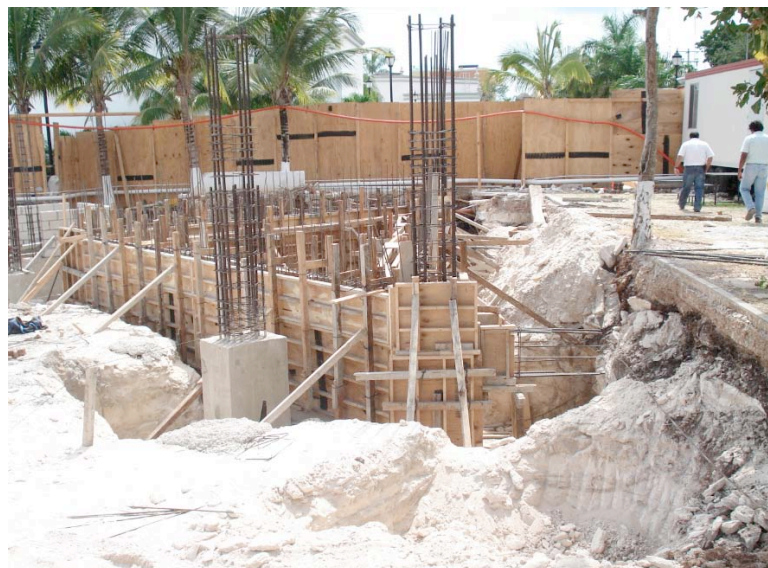
Fig. 6 Muro de concreto armado para sótano
