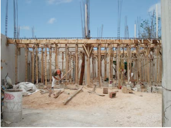
Figura 5. Cimbrado de la estructura
