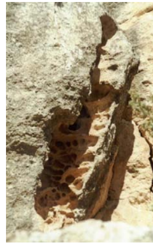
Fig. 2 Grieta kárstica en roca caliza
