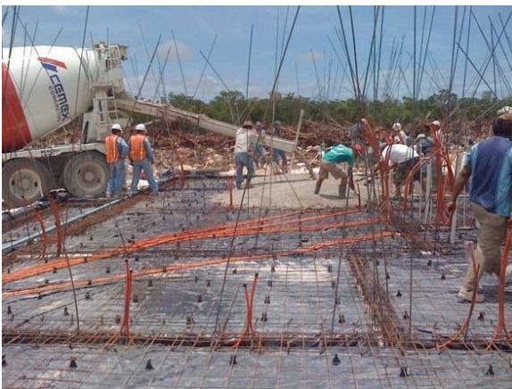
Fig. 5 Colado de la losa de cimentación
