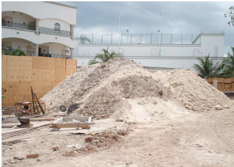
Fig. 7 Producto de la excavación utilizado para relleno compactado al 95% prueba porter estándar.
