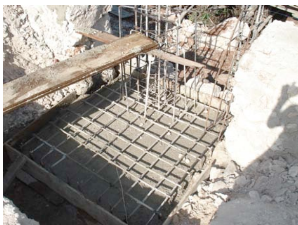
Figura 4. Armado y dados de las zapatas
