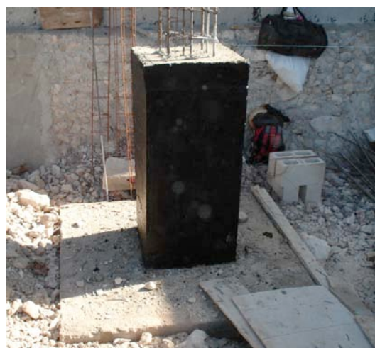
Figura 4. Armado y dados de las zapatas
