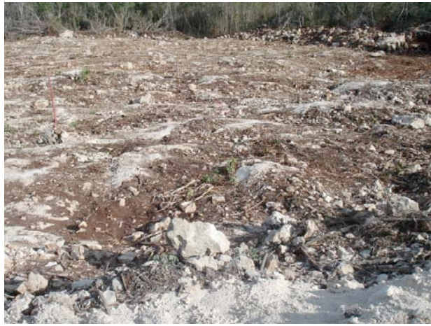
Fig. 1 Terreno donde se cimentará la estructura
