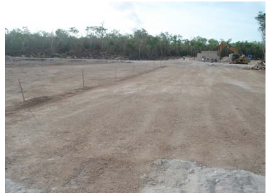
Fig. 3.a Plataforma compactada
