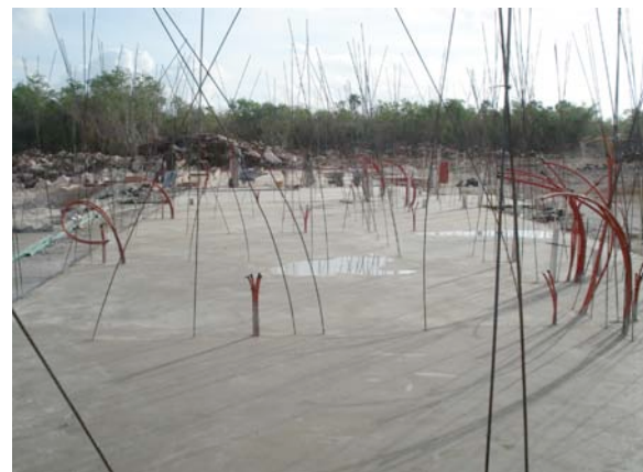
Fig. 5.a Acero estructural de muros de carga
