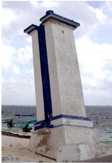
Fig.4 Estructura en Puerto Morelos
