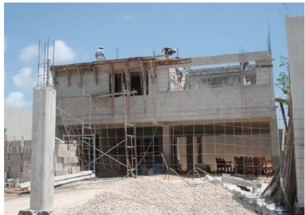
Figura 7. Colado de losa del segundo nivel
