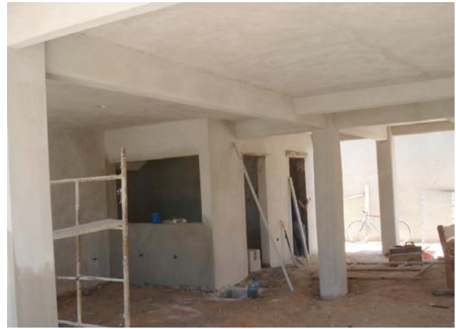
Figura 9. Aplicación de acabados finos
