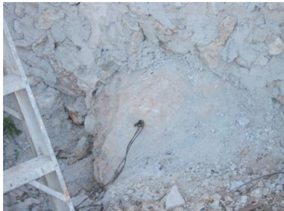
Figura 2.Desplante de cimentación perimetral de mampostería sobre la laja del terreno
