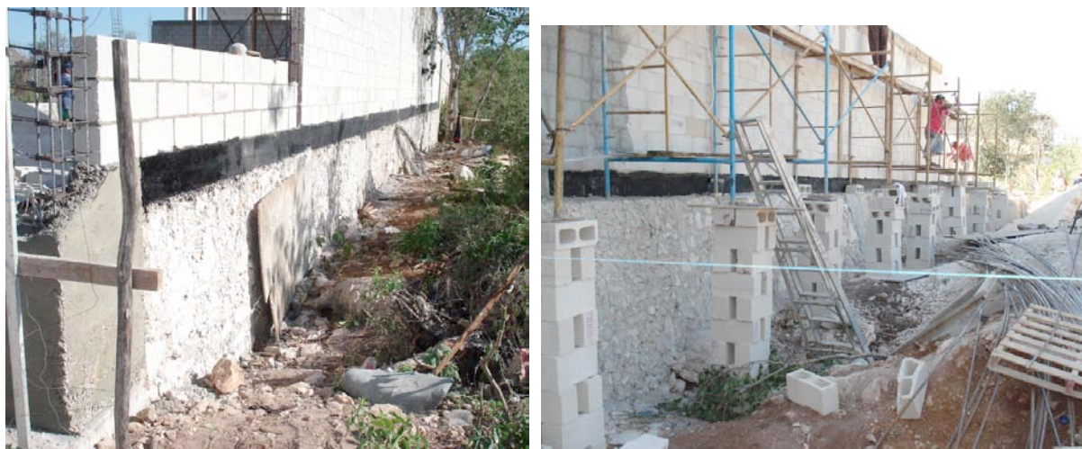
Figura 3. Cimentación de muro perimetral
