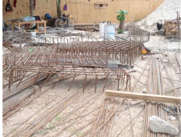
Fig. 3 Habilitado del acero de refuerzo y cimbrado de zapatas
