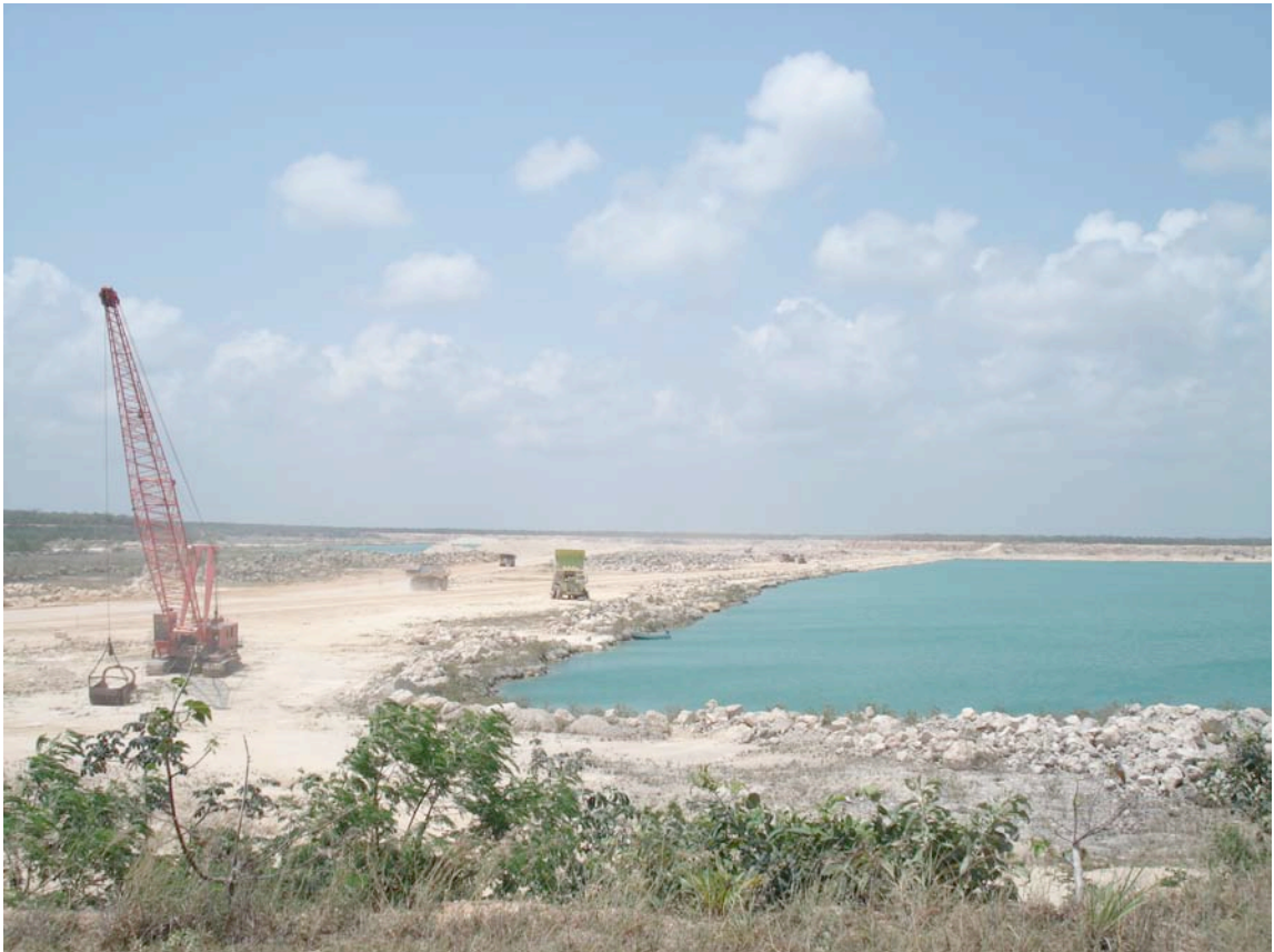
Explotación del banco y alcance del Nivel Freático
