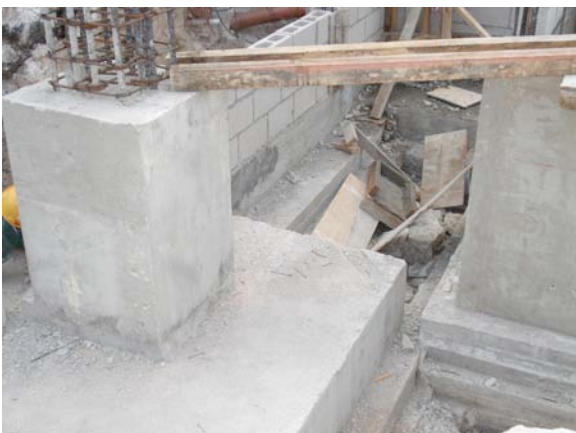
Fig. 5 Zapatas Corridas para desplante de muros de carga de block de concreto
