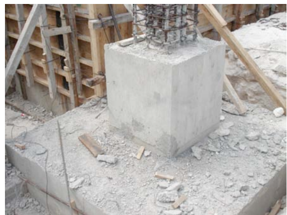
Fig. 5 Zapatas Corridas para desplante de muros de carga de block de concreto
