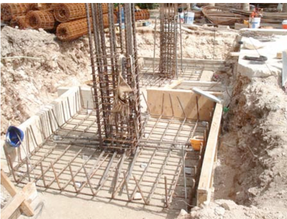
Fig. 3 Habilitado del acero de refuerzo y cimbrado de zapatas
