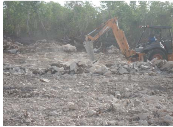
Fig. 2.a Nivelación del terreno para la plataforma
