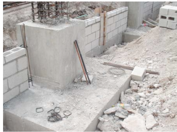
Fig. 4 Colado de Zapata Aisladas y contratrabe de cimentación que une la cimentación
