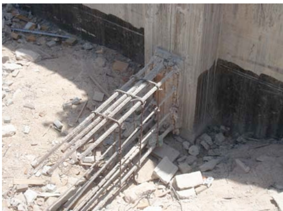
Fig. 8 Impermeabilización y Relleno de la excavación para construcción de la estructura
