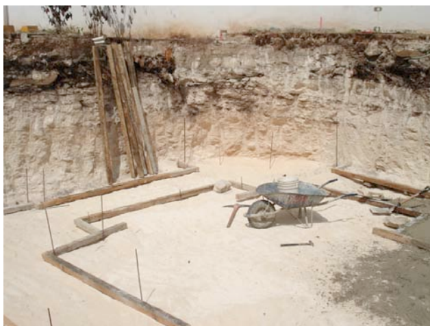
Fig. 1 Excavación para desplante de zapatas
