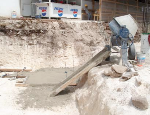
Fig. 2 Plantillas de concreto pobre f'c=150 Kg./cm 2 para desplante de zapatas aisladas
