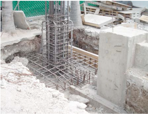
Fig. 4 Colado de Zapata Aisladas y contratrabe de cimentación que une la cimentación
