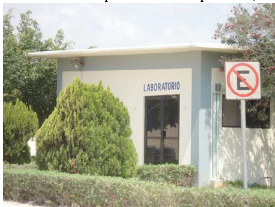
Laboratorio de control de calidad
