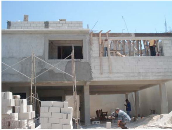
Figura 8. Preparación losa a dos aguas
