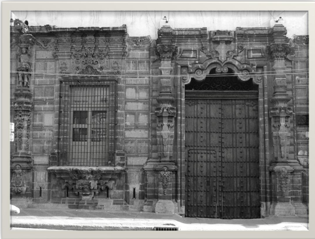
Ilustración 1 Fachada principal de la Casa de los Mascarones en la actualidad.
