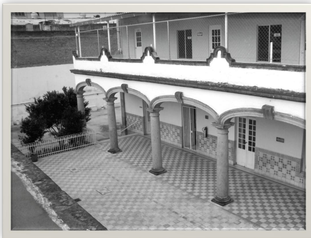
Ilustración 26. Vista parcial de la azotea en Cedro 16
