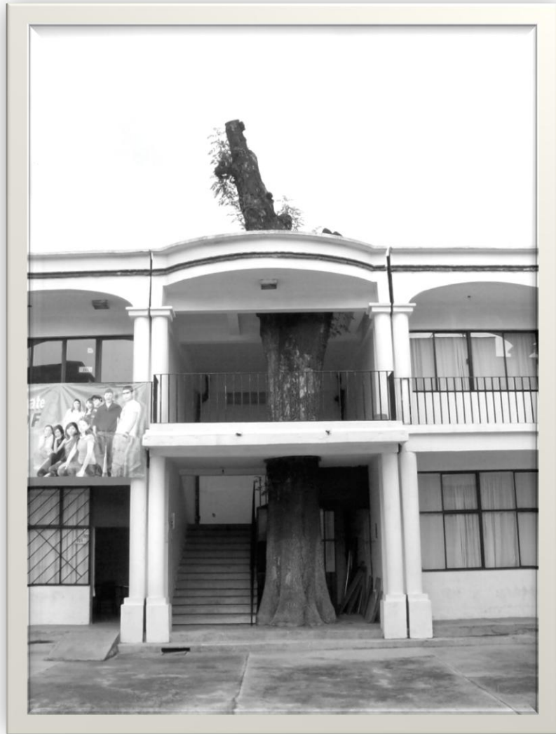
Ilustración 30. Construcción de la parte trasera de la casa de Cedro 16
