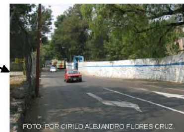
Planta de tratamiento de agua.
